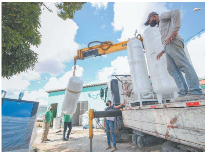
Primeiros torpedos de armazenamento de gás chegaram ontem e já foram instalados
