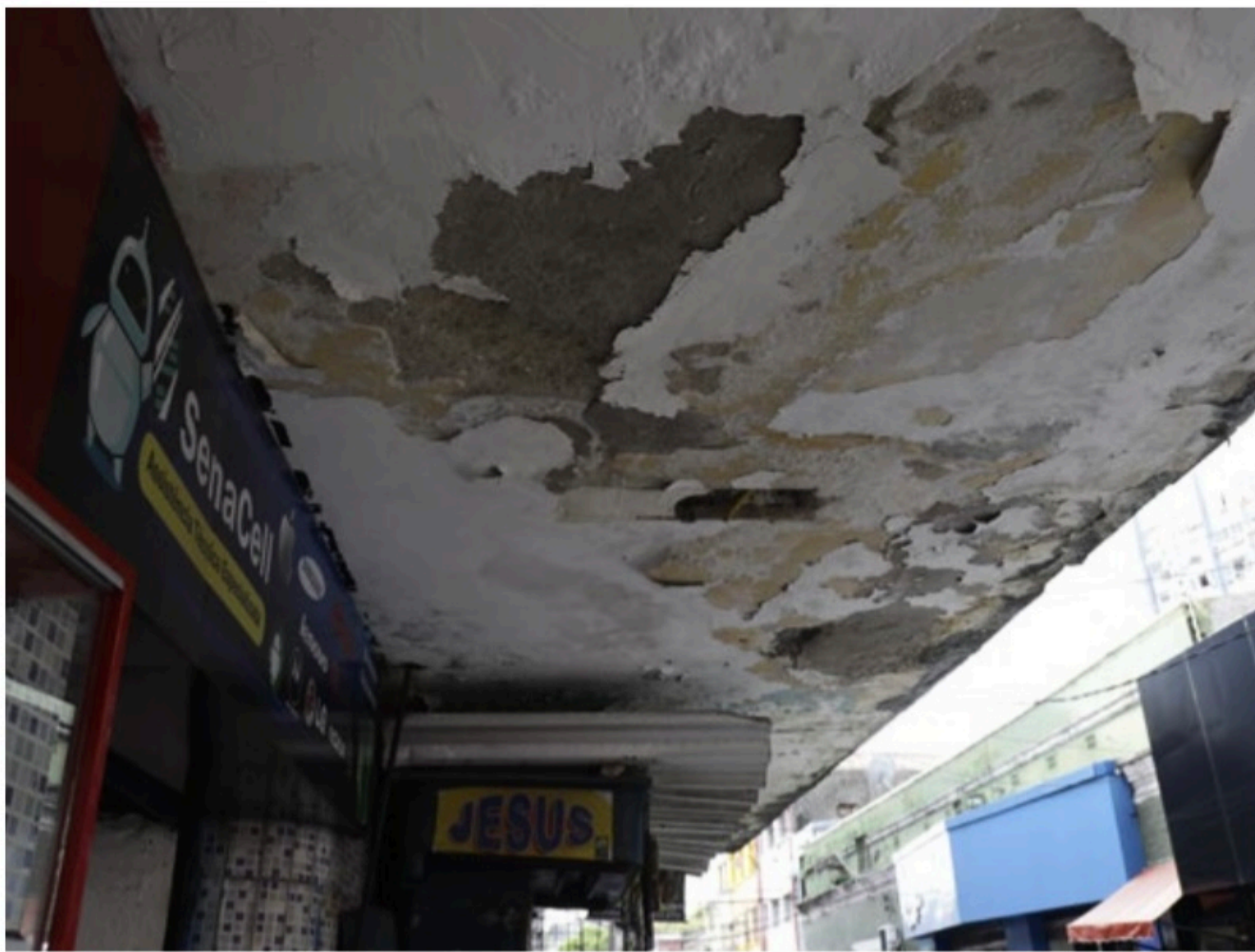
PROCESSO Poder Municipal precisou entrar com ação judicial para obrigar os condôminos a realizarem manutenção na estrutura do imóvel
