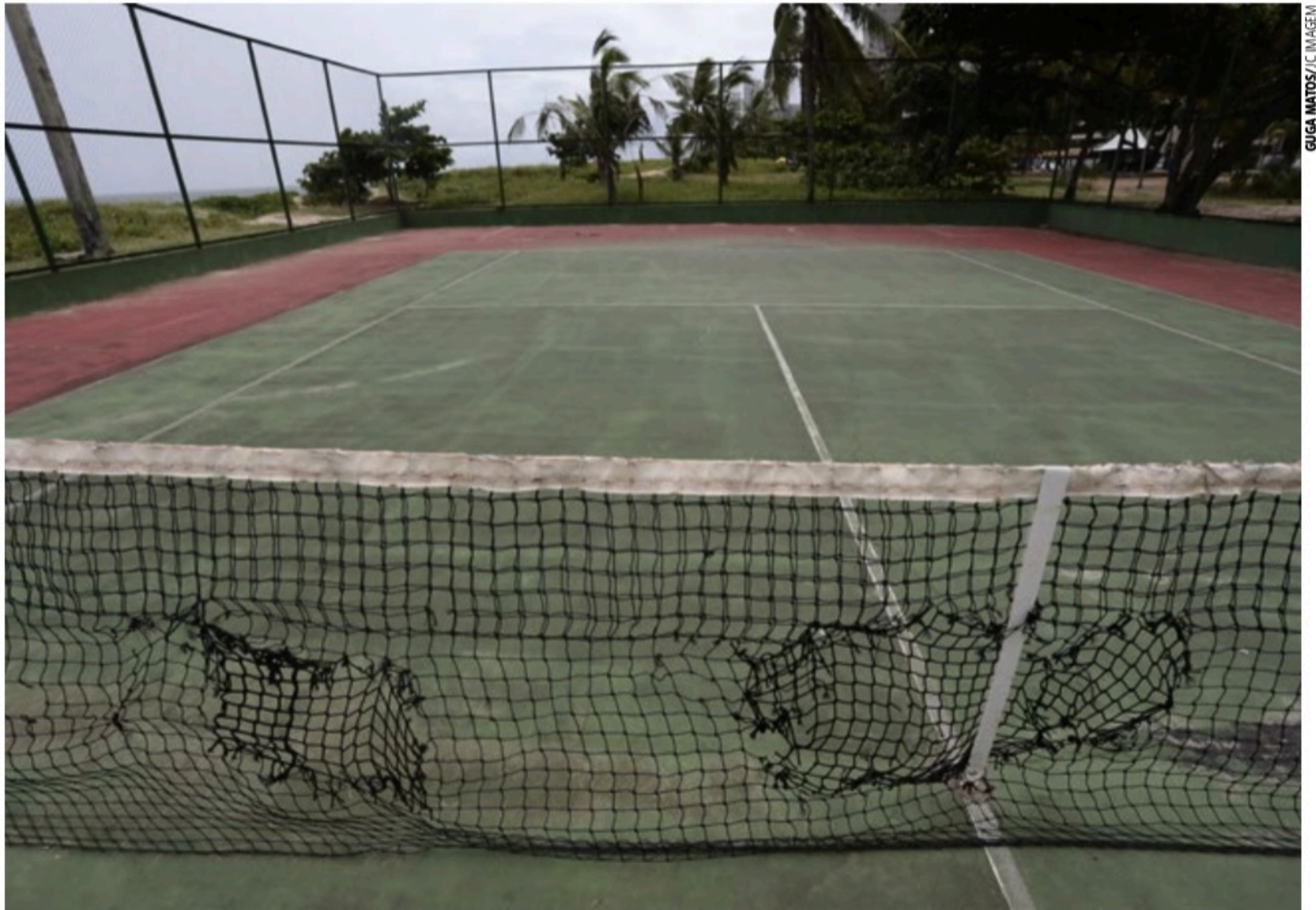
SEM ESTRUTURA BÁSICA Quadras de vôlei estão com redes danificadas e hastes de sustentação da rede foram retiradas. Quem frequenta o local para praticar o esporte, reclama
