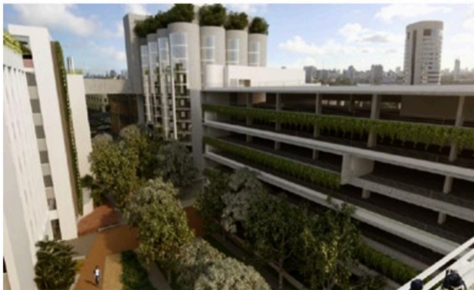
MOINHO RECIFE Empreendimento em obras prevê retrofit dos silos e ocupação que inclui hotel e residencial
