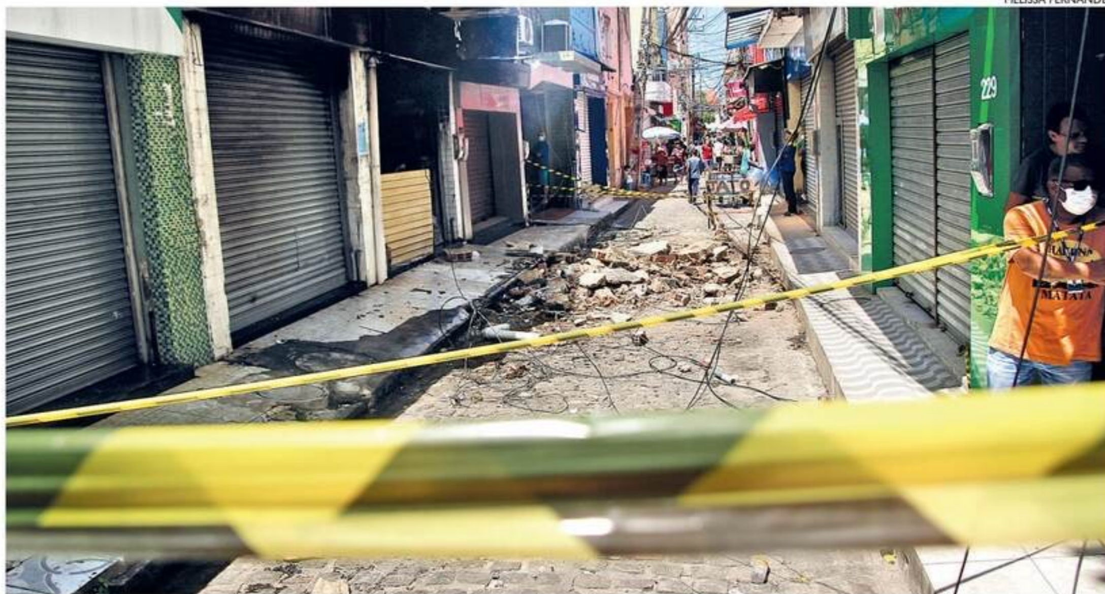
Área foi isolada e só deve ser liberada após a realização da derrubada dos pavimentos superiores
