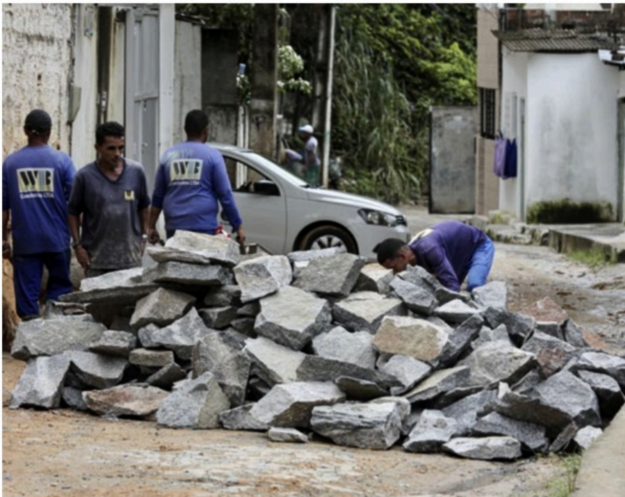
REFORÇO Prefeitura diz que 12 obras estão em andamento, enquanto outras 12 ainda estão para ser iniciadas na Zona Norte da capital
