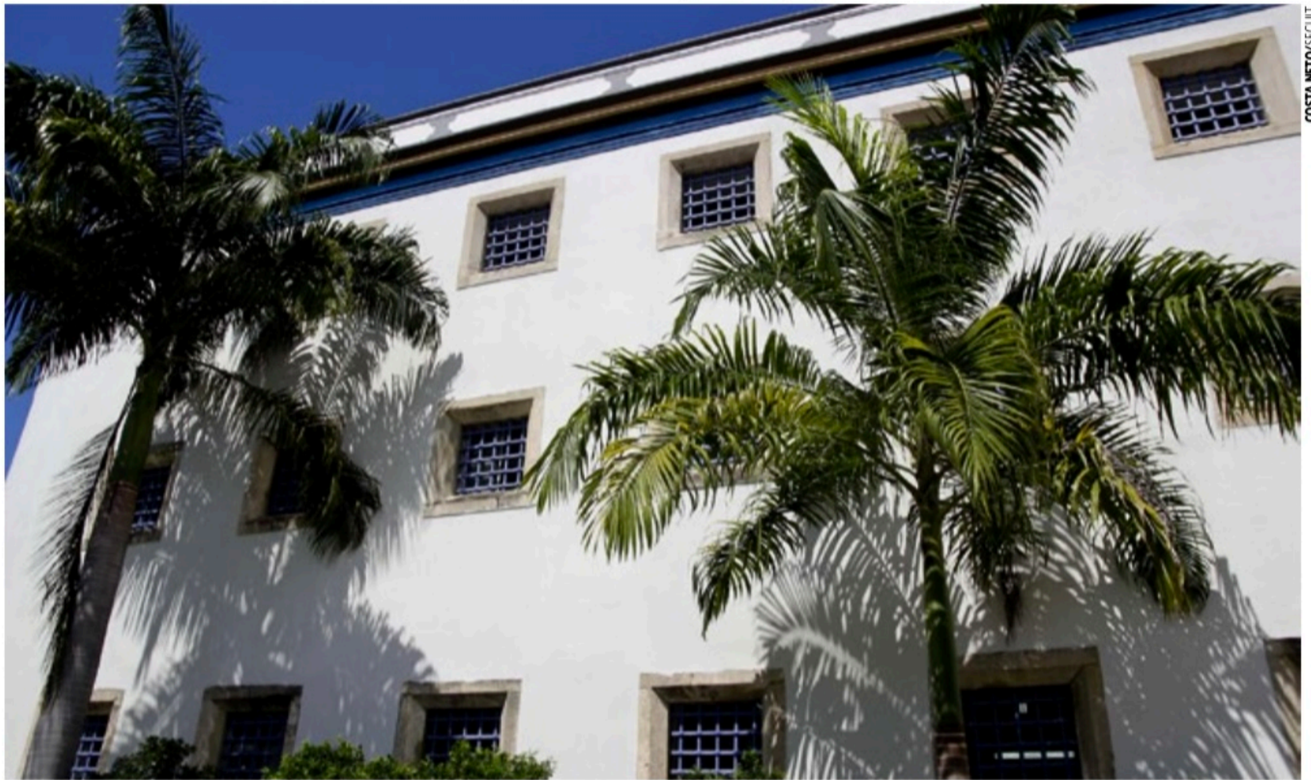
EQUIPAMENTO Casa da Cultura receberá a maior fatia de investimento: pouco mais de R$ 3,1 milhões, para serviços na recuperação da estrutura e nova iluminação na área externa
