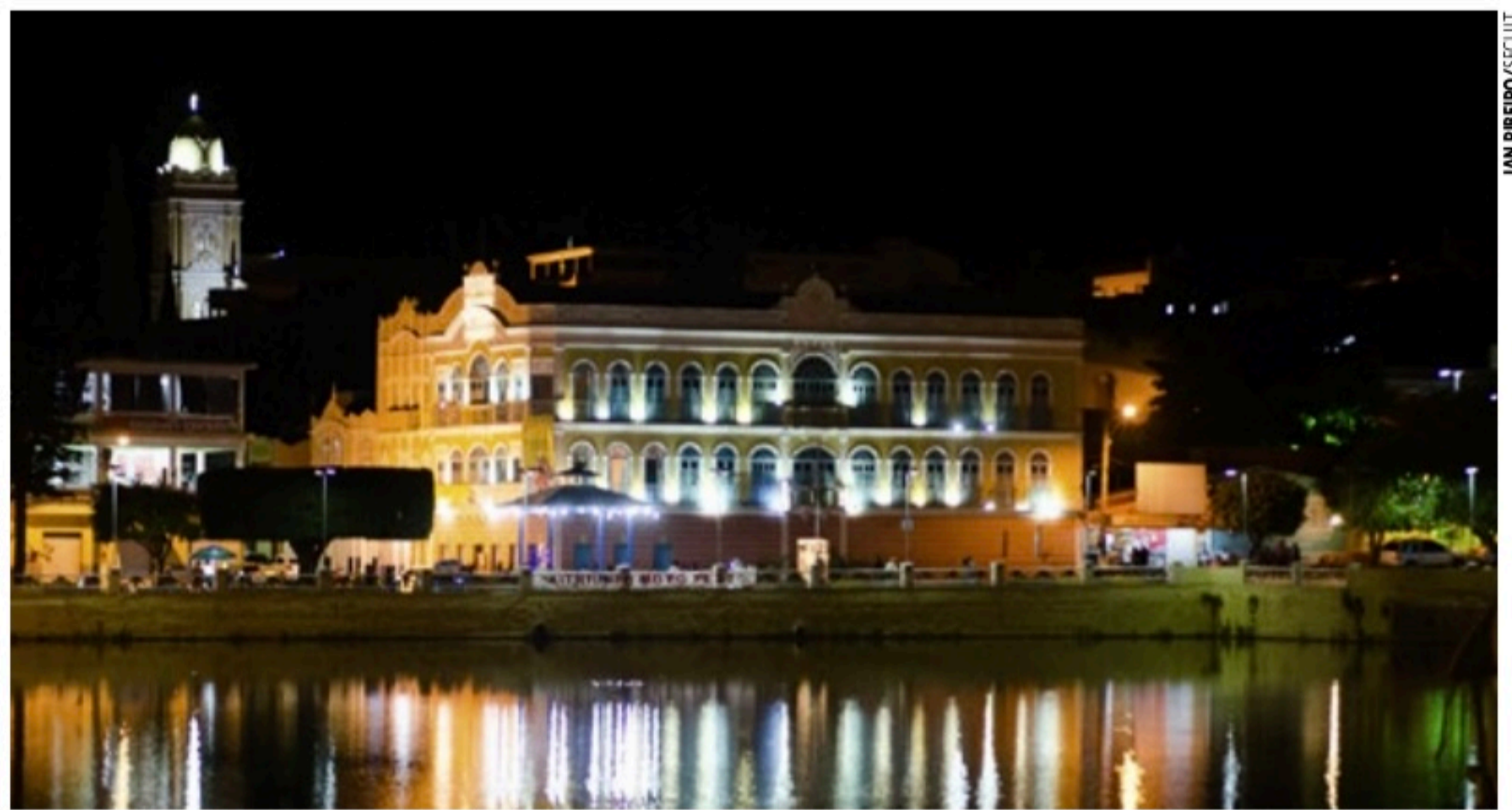
CENTENÁRIO Theatro Cinema Guarany, em Triunfo, completará cem anos com novas poltronas, serviços de requalificação e sistema de climatização
