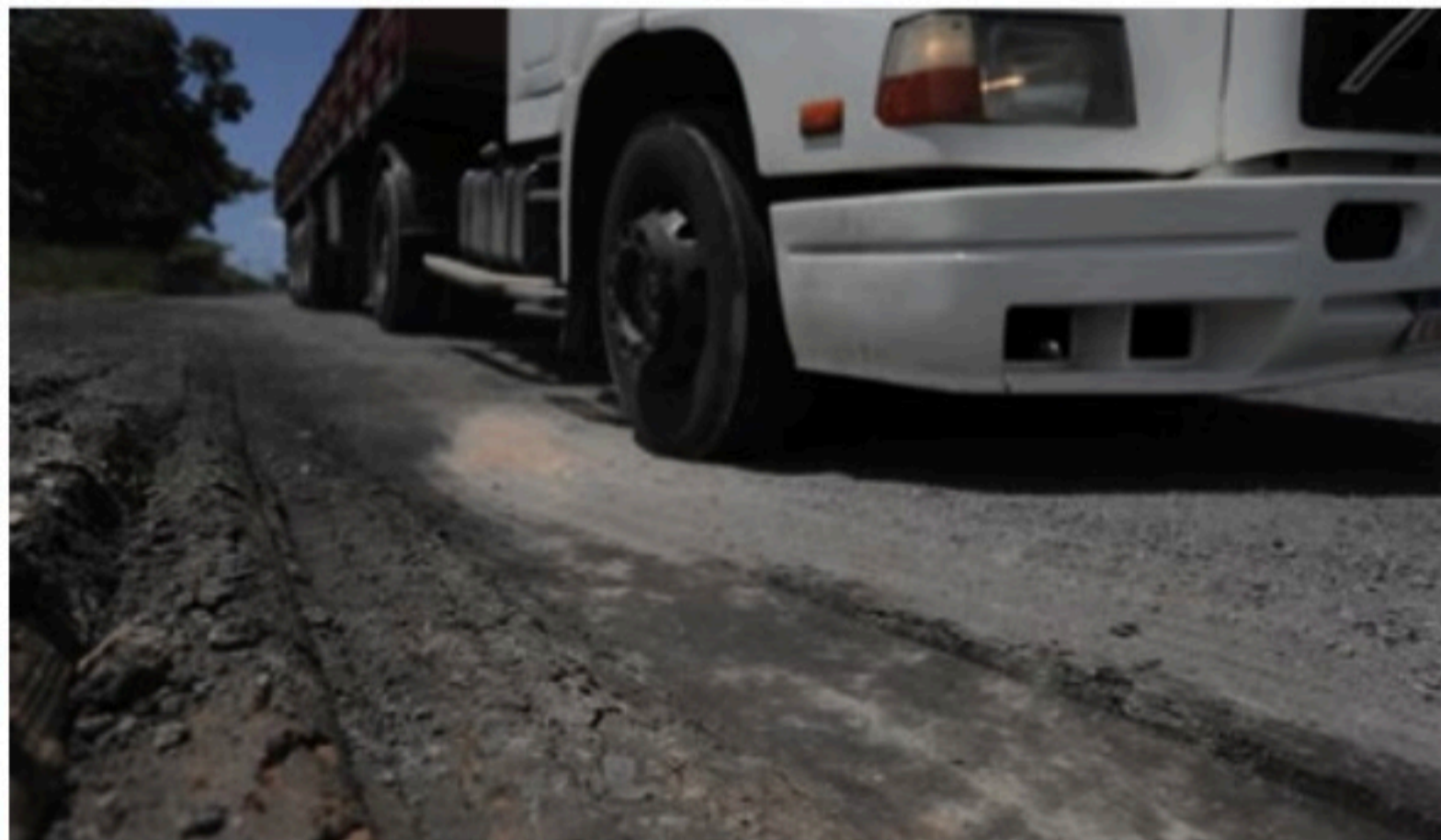
ATENÇÃO REDOBRADA Trechos da BR-232 continuam com problemas, aumentando risco de sinistros
