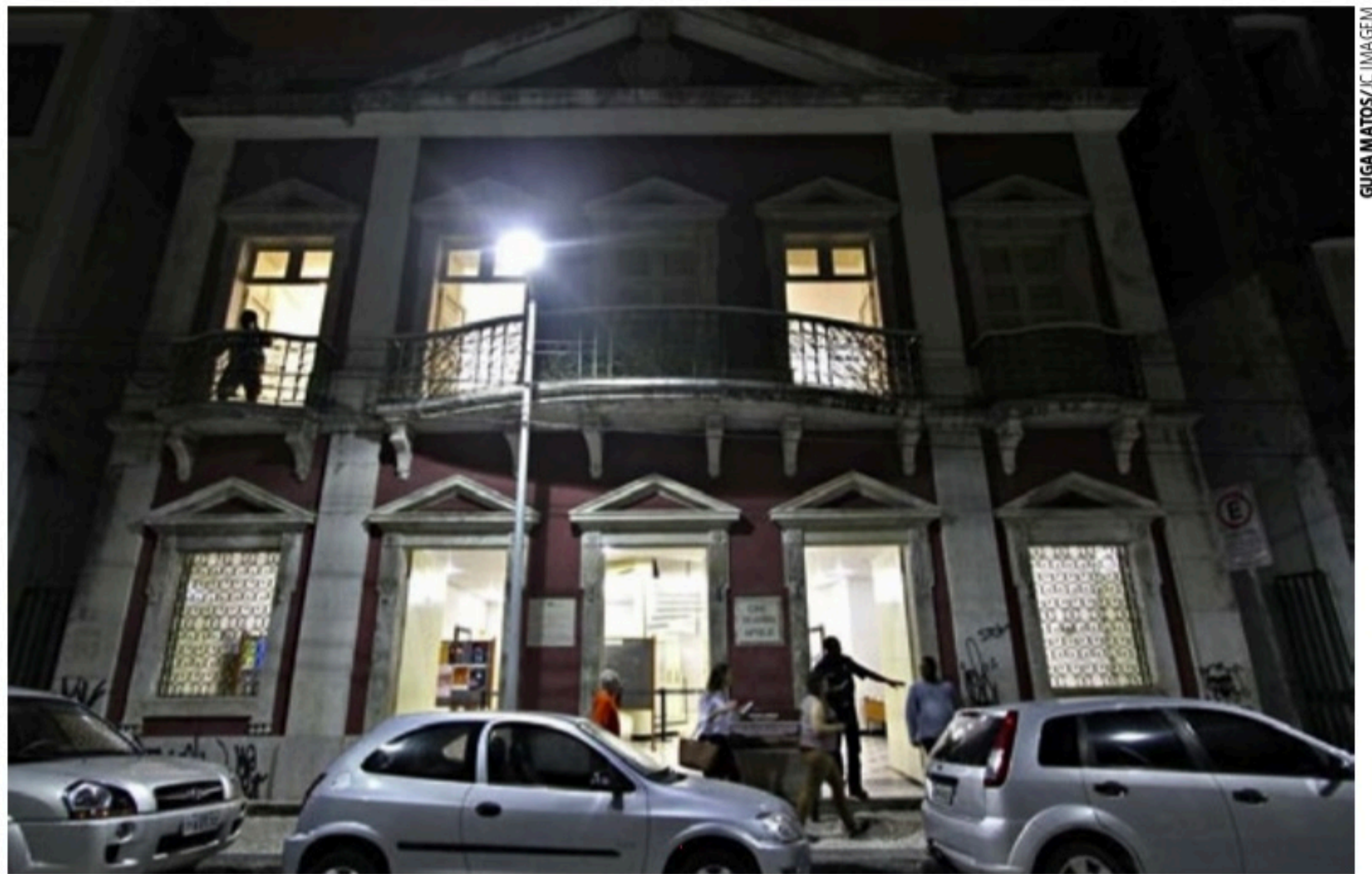
VERSÁTIL Fundado para as artes cênicas em 1839, equipamento foi aproveitado como sala de cinema em 1996, numa revitalização do Bairro do Recife
