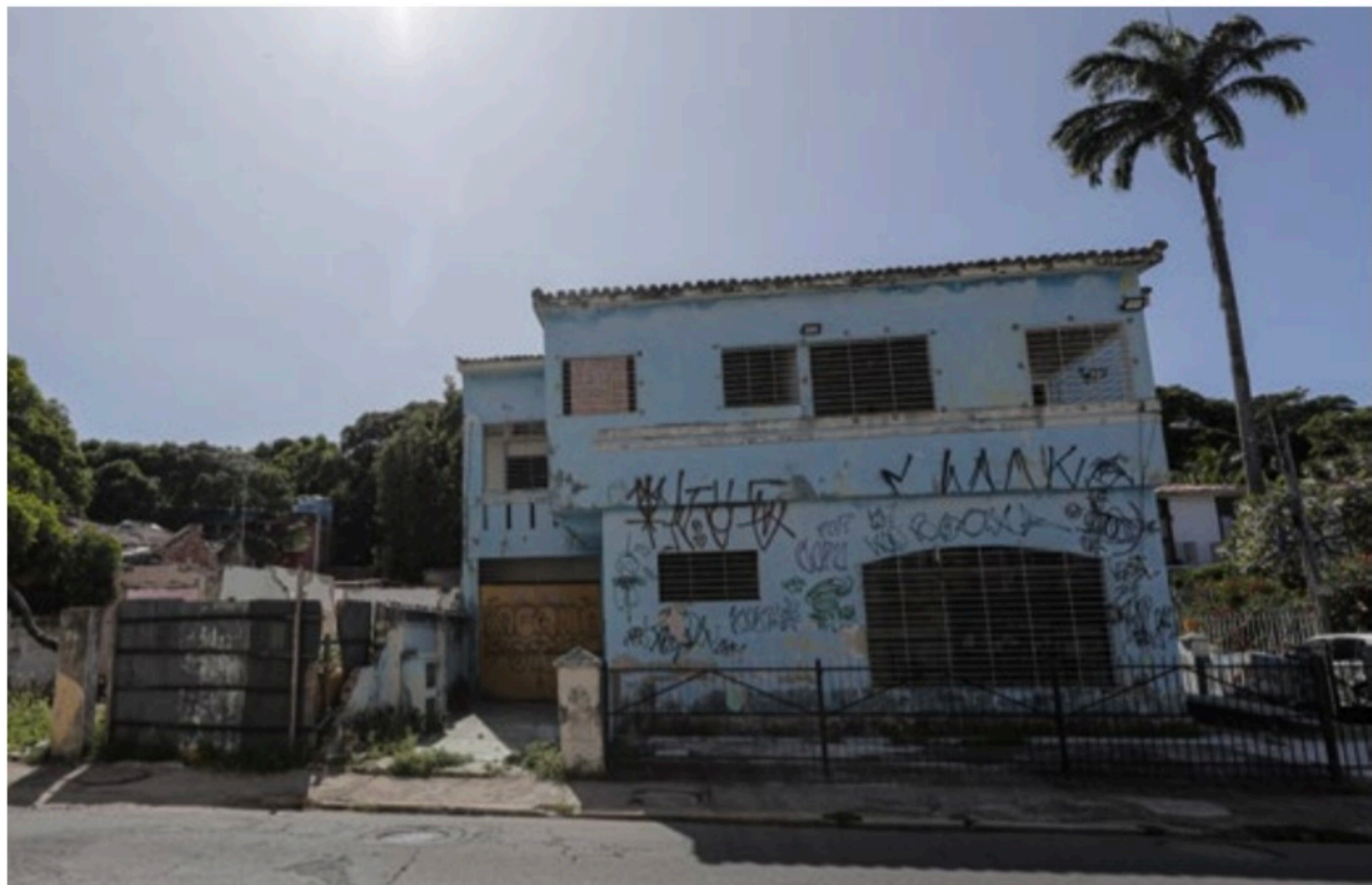
VANDALISMO Pichações e problemas estruturais em casarões históricos de Olinda evidenciam a falta de zelo por parte da gestão municipal
