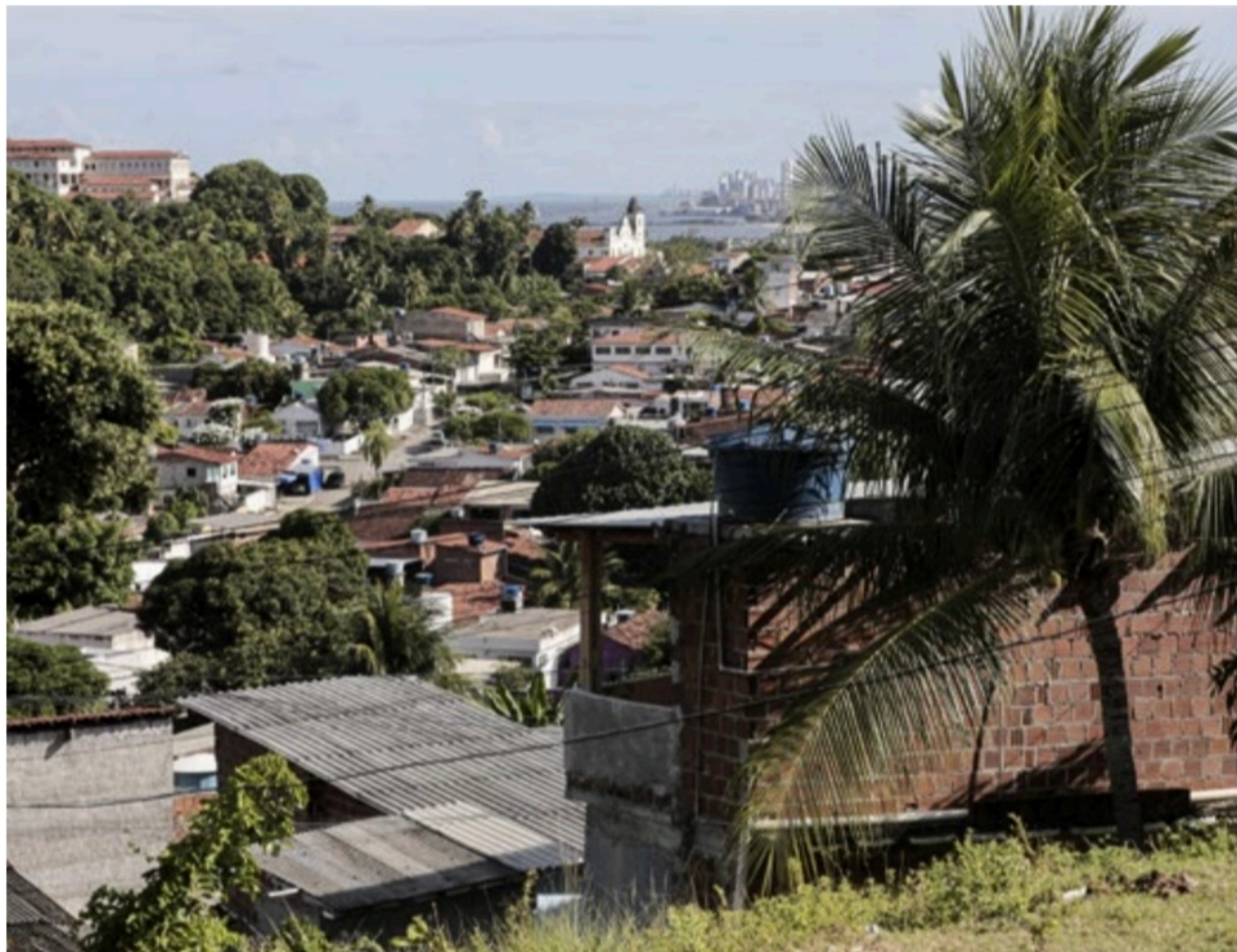
SEM FISCALIZAÇÃO Construções irregulares são cada vez mais comuns, inclusive com quantidade de pavimentos acima do permitido por lei
