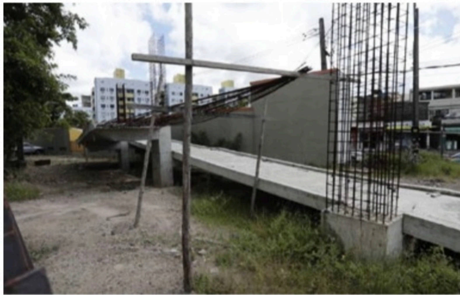
PELA METADE Até a interrupção dos serviços, havia sido fundado o pilar central da passarela e parte da rampa
