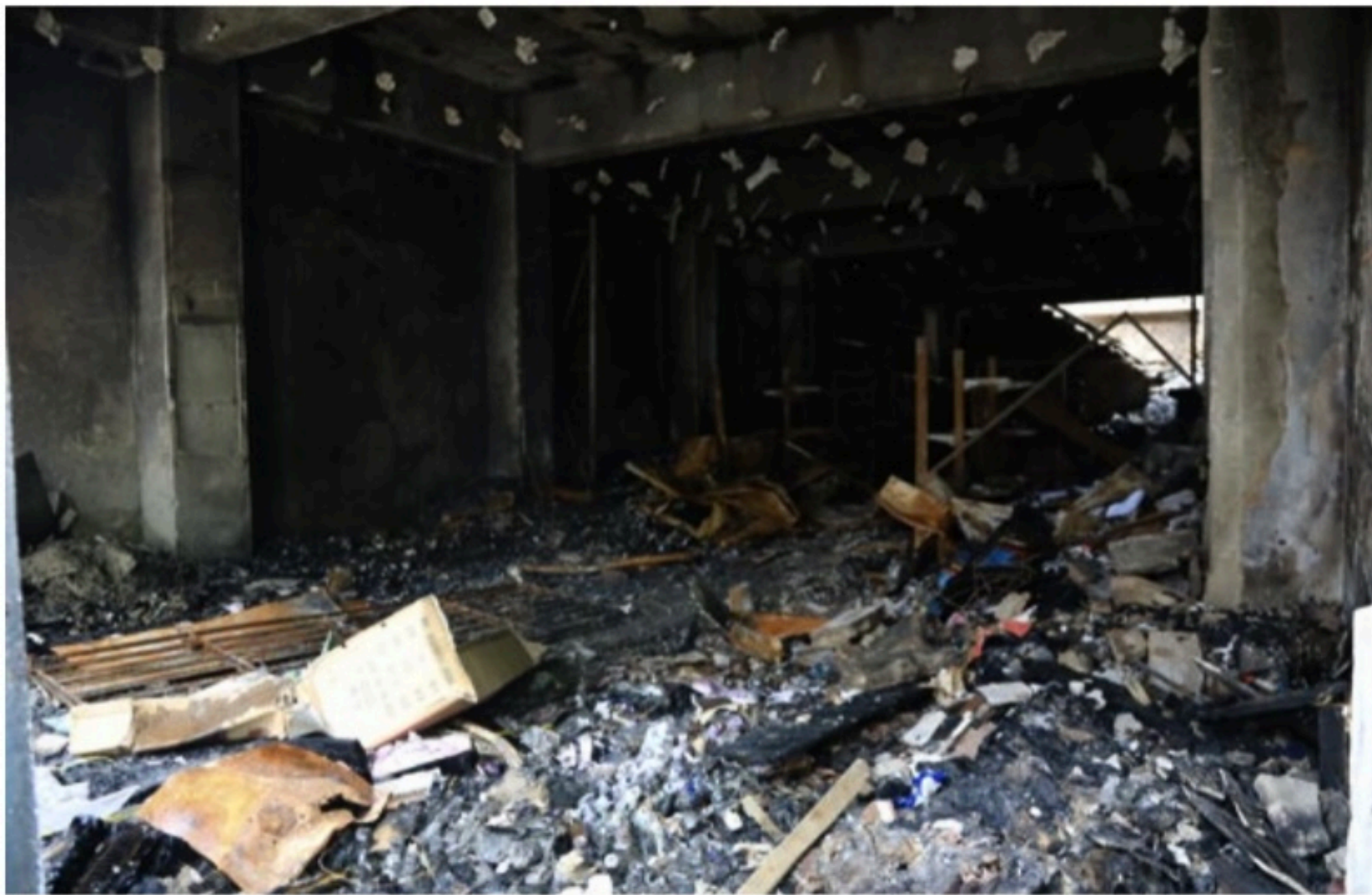
TRANSTORNOS Por causa dos materiais inflamáveis, o fogo se alastrou mais rapidamente pela loja, que ficou completamente destruída
