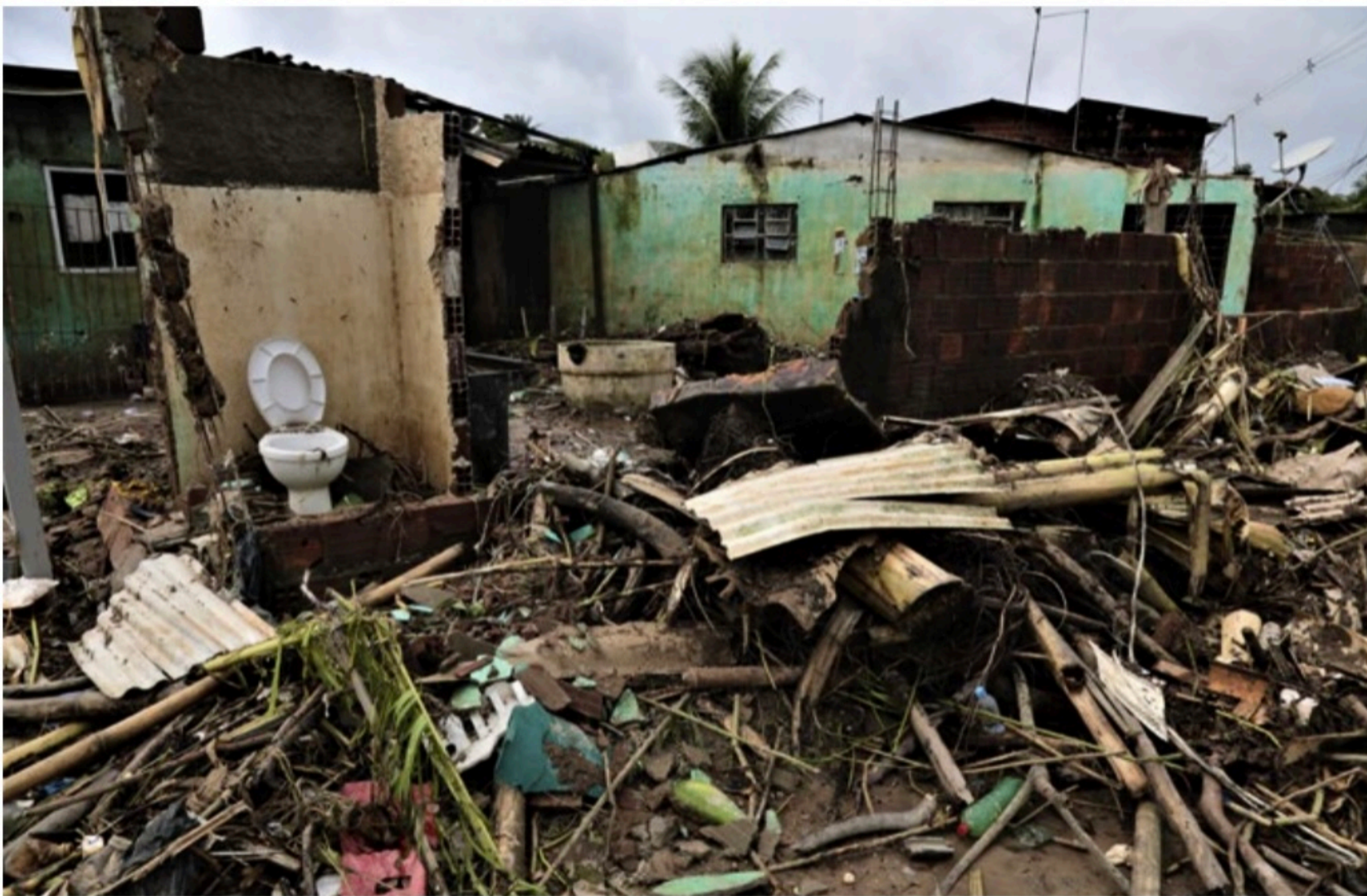
DEVASTADOR Em um dos imóveis em Socorro, sobrou apenas um vaso sanitário e um pedaço da parede. Moradores não tem ideia de onde vão viver a partir de agora
