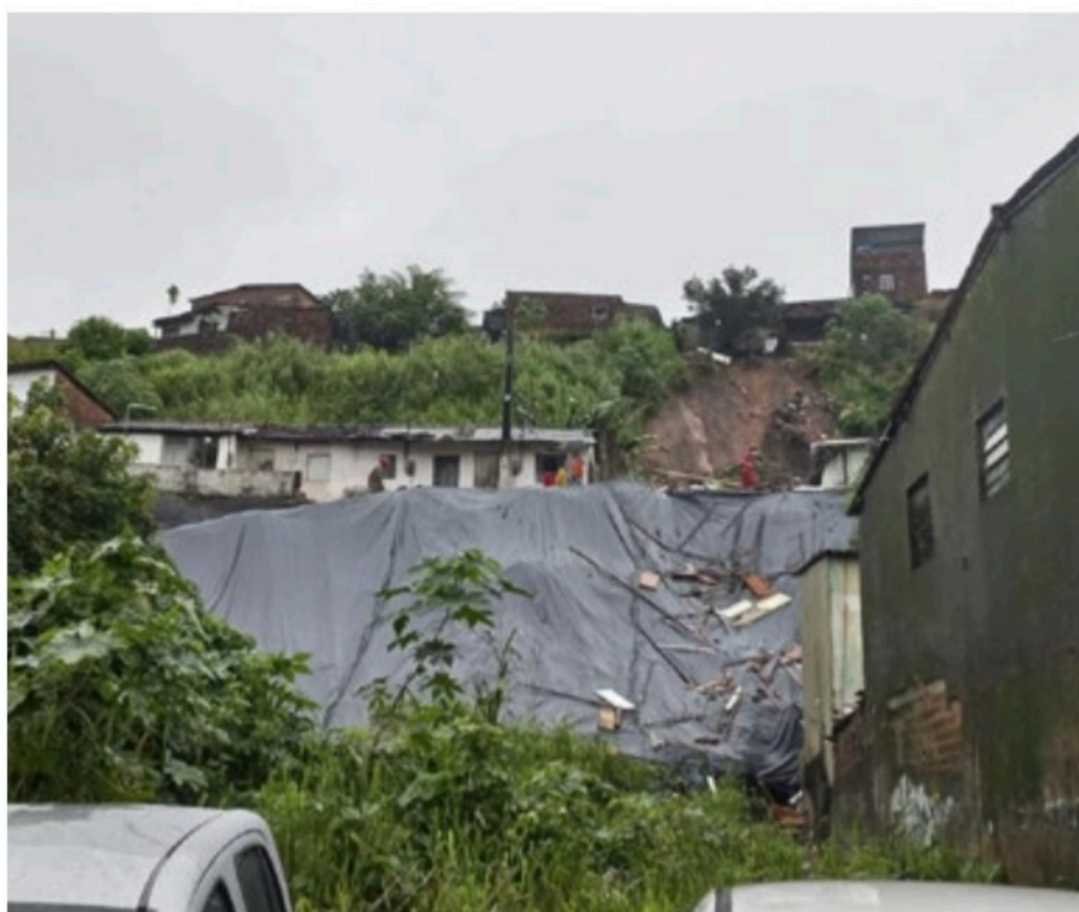
DESESPERO Barreira que deslizou ontem pela manhã atingiu cinco casas no Alto de Santa Terezinha
