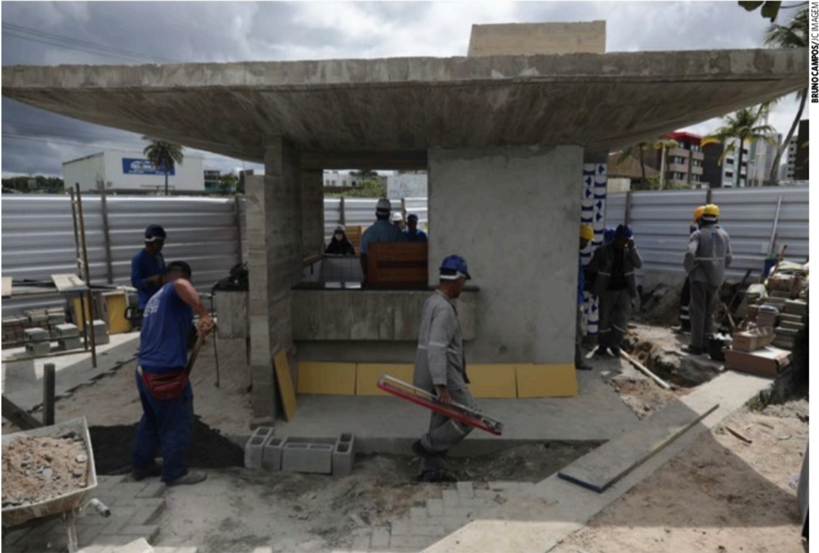
TRABALHOS Quiosques de número 58 e 59, que ficam mais próximos da Praia de Piedade, em Jaboatão, estão mais avançados. Na sexta-feira, havia muitos pedreiros nos equipamentos
