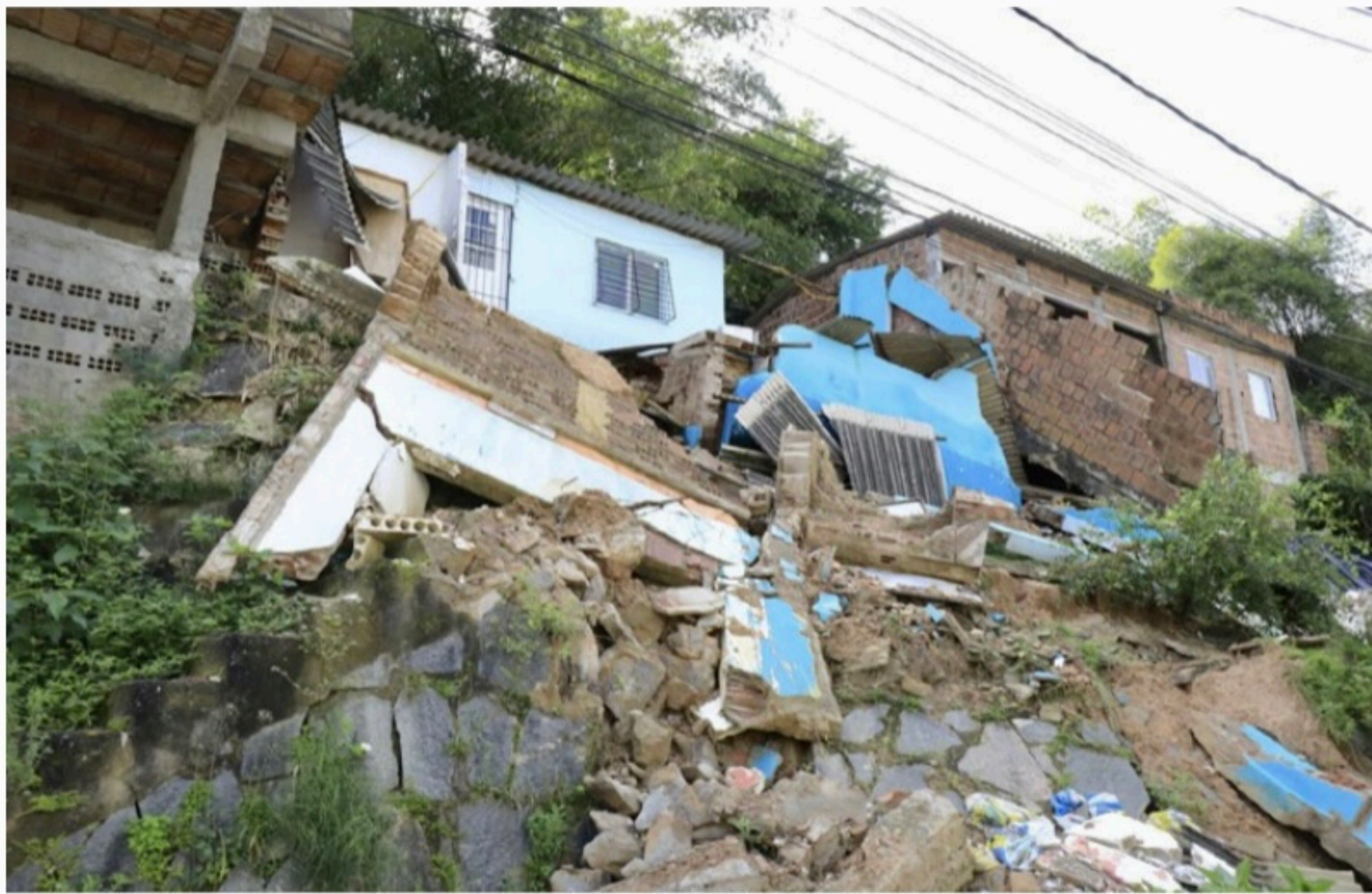
DESTROÇOS Cenário da barreira que fica na Rua Engenheiro Célio de Carli é de destruição. Famílias vivem com medo de outro deslizamento
