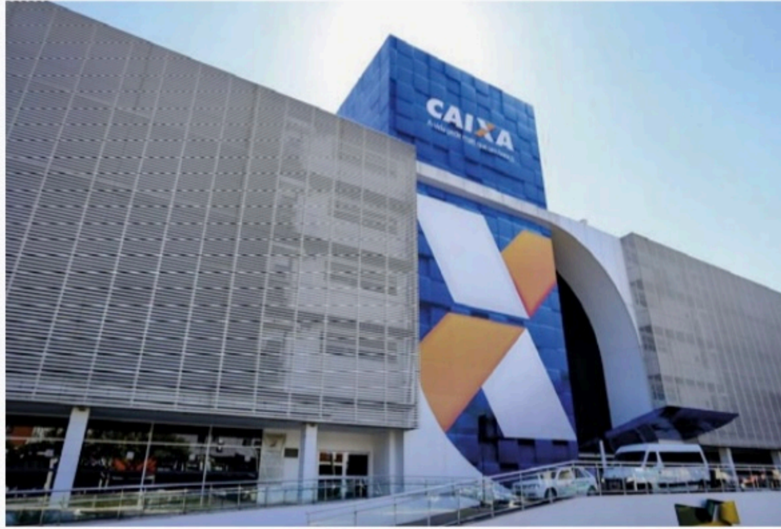
BRASÍLIA Corpo foi encontrado na noite da terça-feira na área externa do edifício-sede da Caixa
