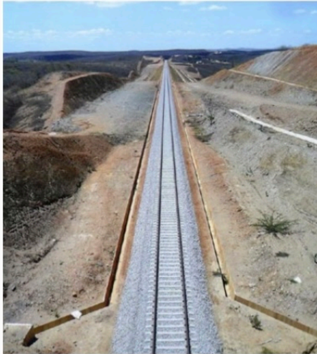
INFRAESTRUTURA Ferrovia começou a ser construída ainda em 2006
