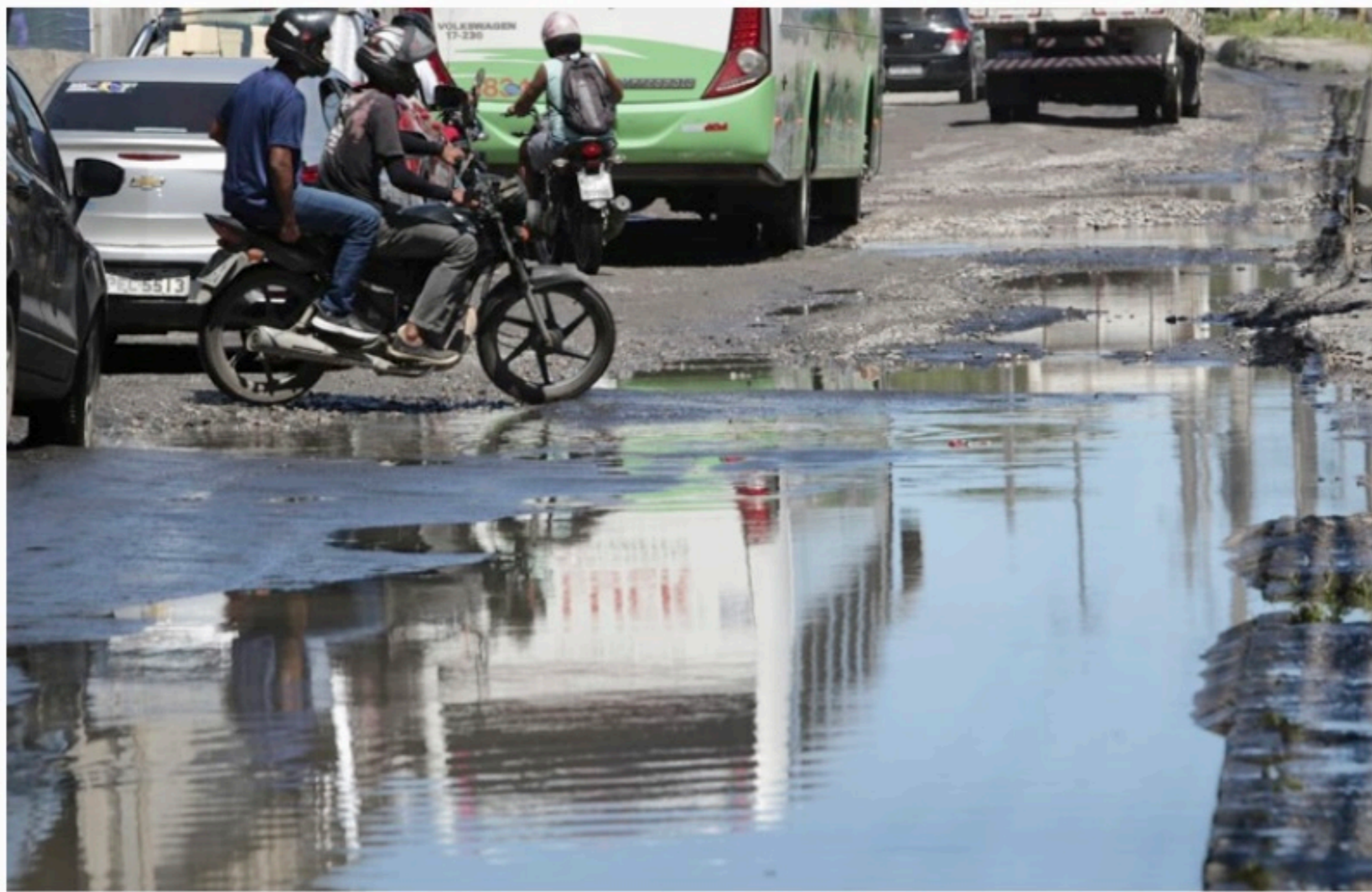
MAIS PROBLEMAS Além da buraqueira, o esgoto a céu aberto também dificulta a mobilidade de quem precisa passar na Presidente Kennedy
