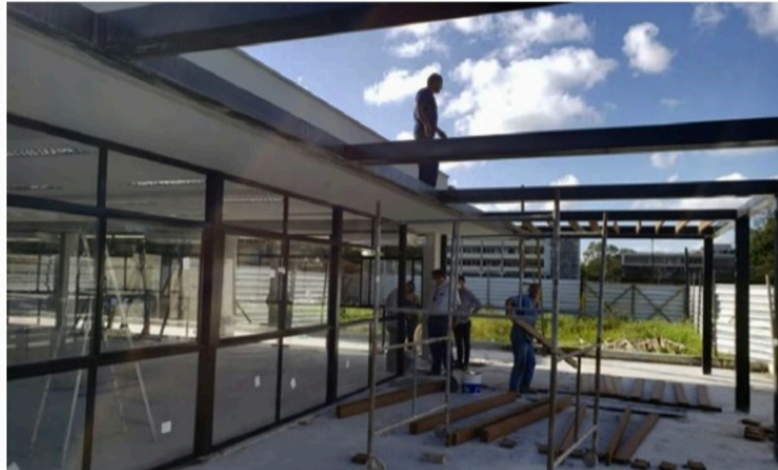
EM OBRAS Reforma no restaurante universitário deve acabar em setembro. Investimento é de R$ 2 milhões
