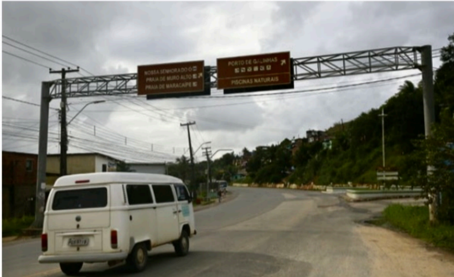
AMPLIAÇÃO Pista principal da rodovia passará a ter 14 metros de largura, sendo sete em cada sentido
