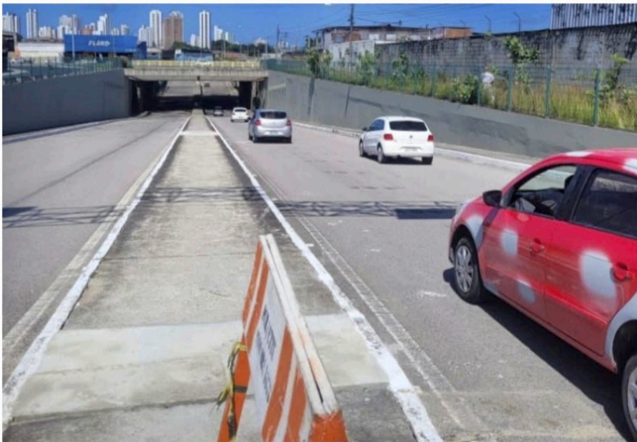
TRÁFEGO Veículos voltaram a circular normalmente pelo túnel, que fica na Zona Sul do Recife, desde a tarde da última segunda-feira
