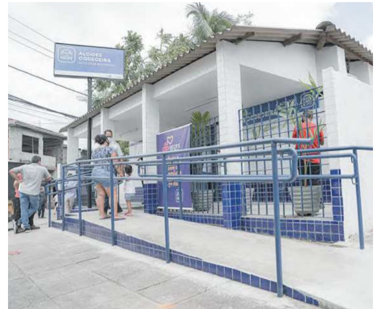
USF faz parte de lista de 145 pontos que serão reformados
