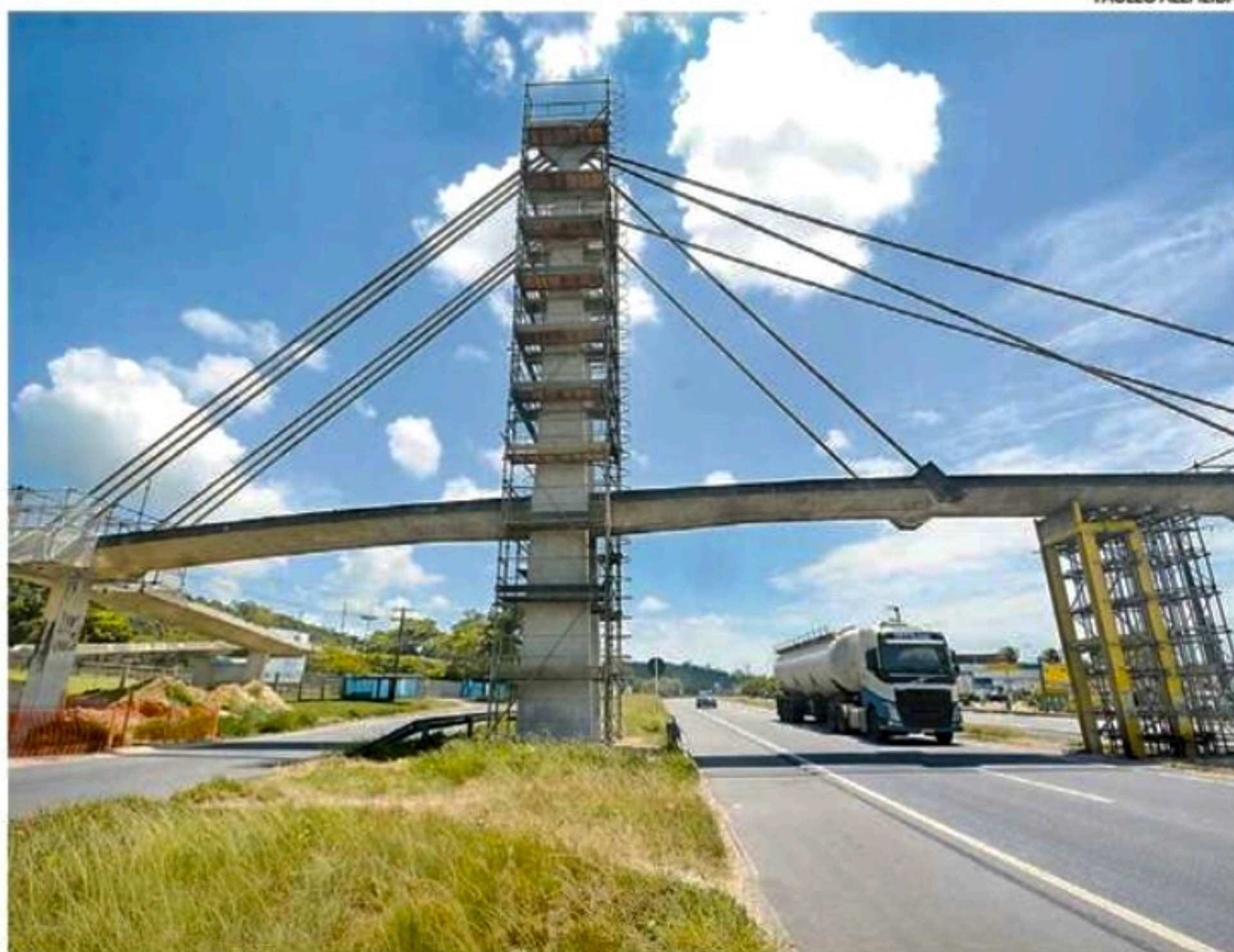
Para as obras serem realizadas, haverá a interdição de faixa e o desvio de tráfego na rodovia
