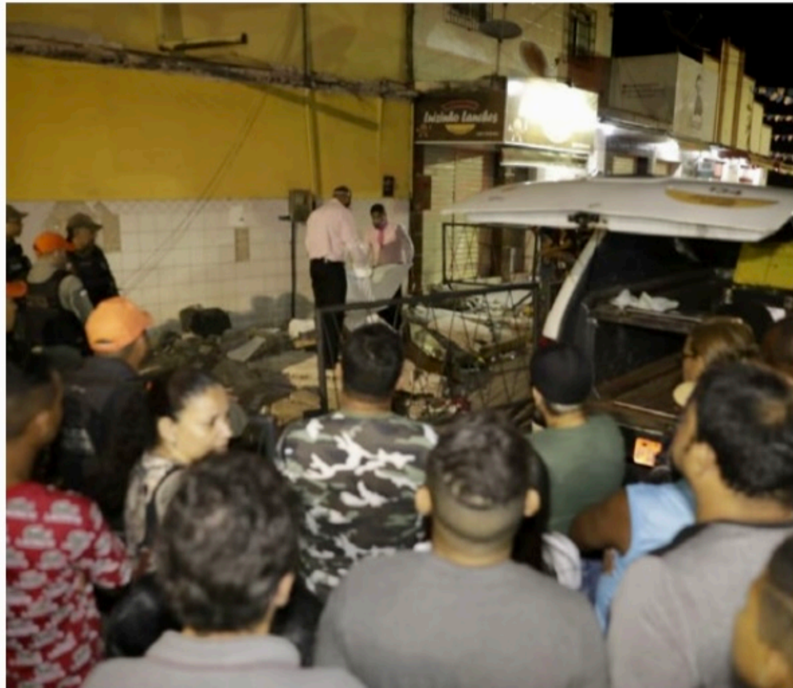
DESASTRE Várias pessoas acompanhavam o desfile quando a fachada do estabelecimento comercial cedeu
