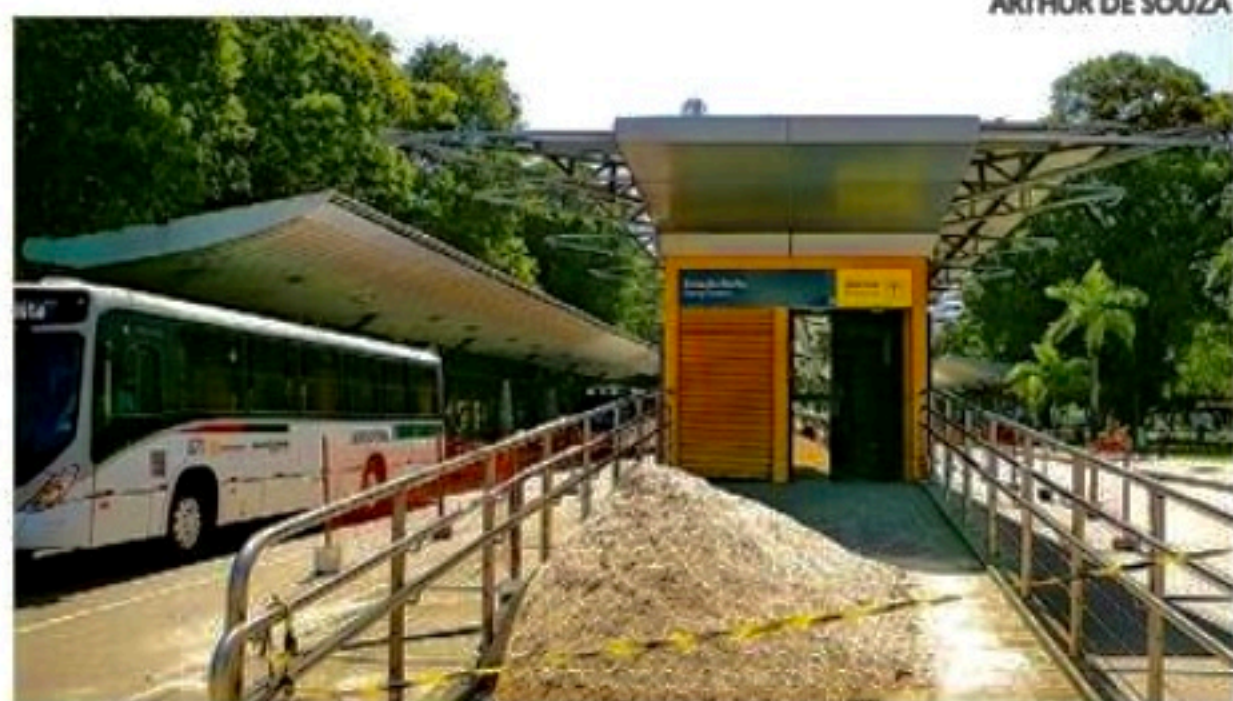
Reforma em espaço provoca interdição de via no Derby
