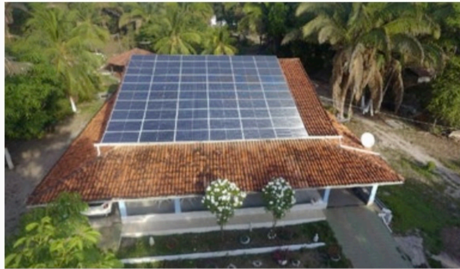
POTÊNCIA País supera marca histórica de 19 gigawatts de potência instalada de energia solar fotovoltaica
