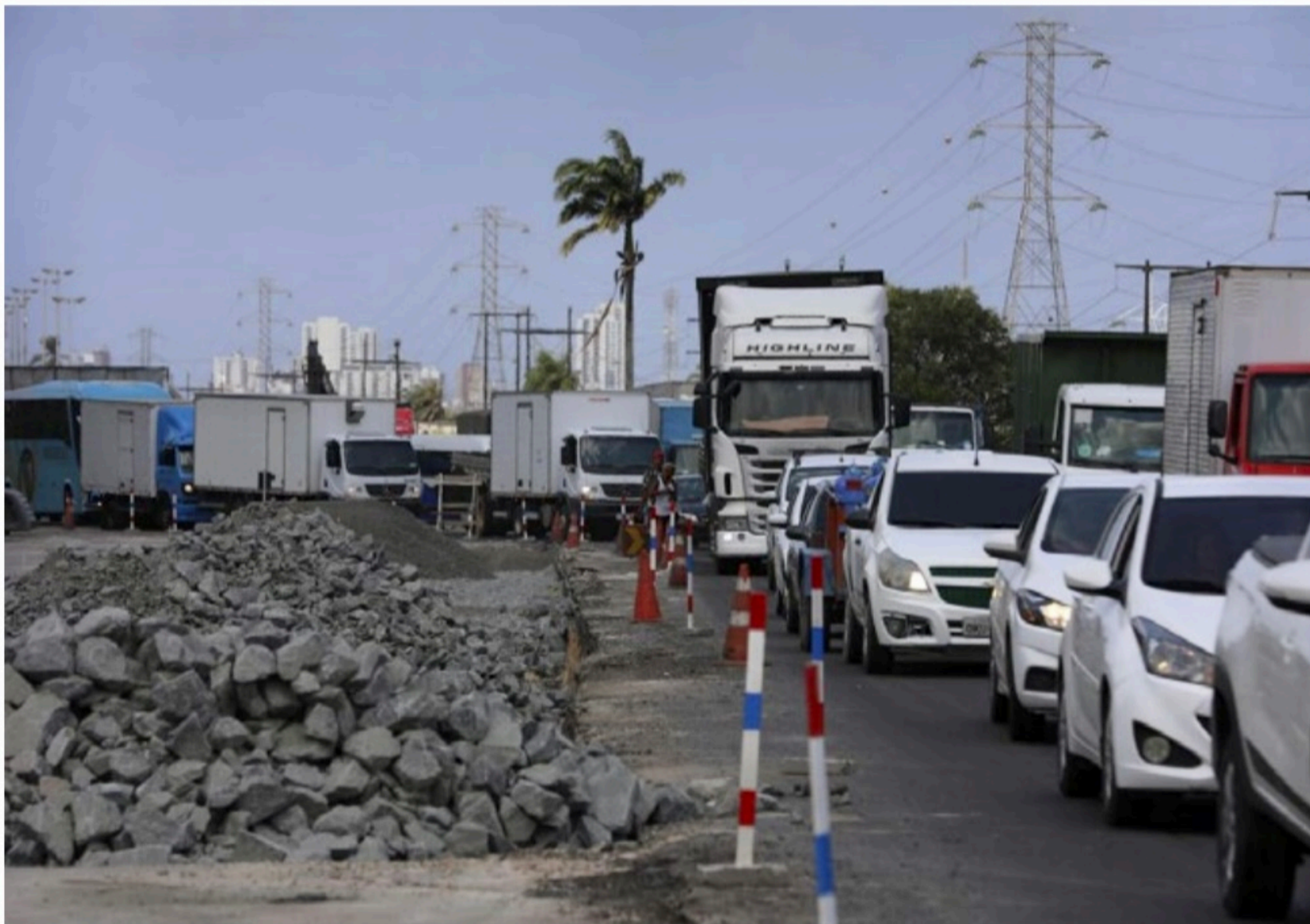
TRANSTORNOS Desde que os trabalhos foram iniciados, em março, motoristas sofrem com os congestionamentos. Problema está mais perto de acabar, promete o governo
