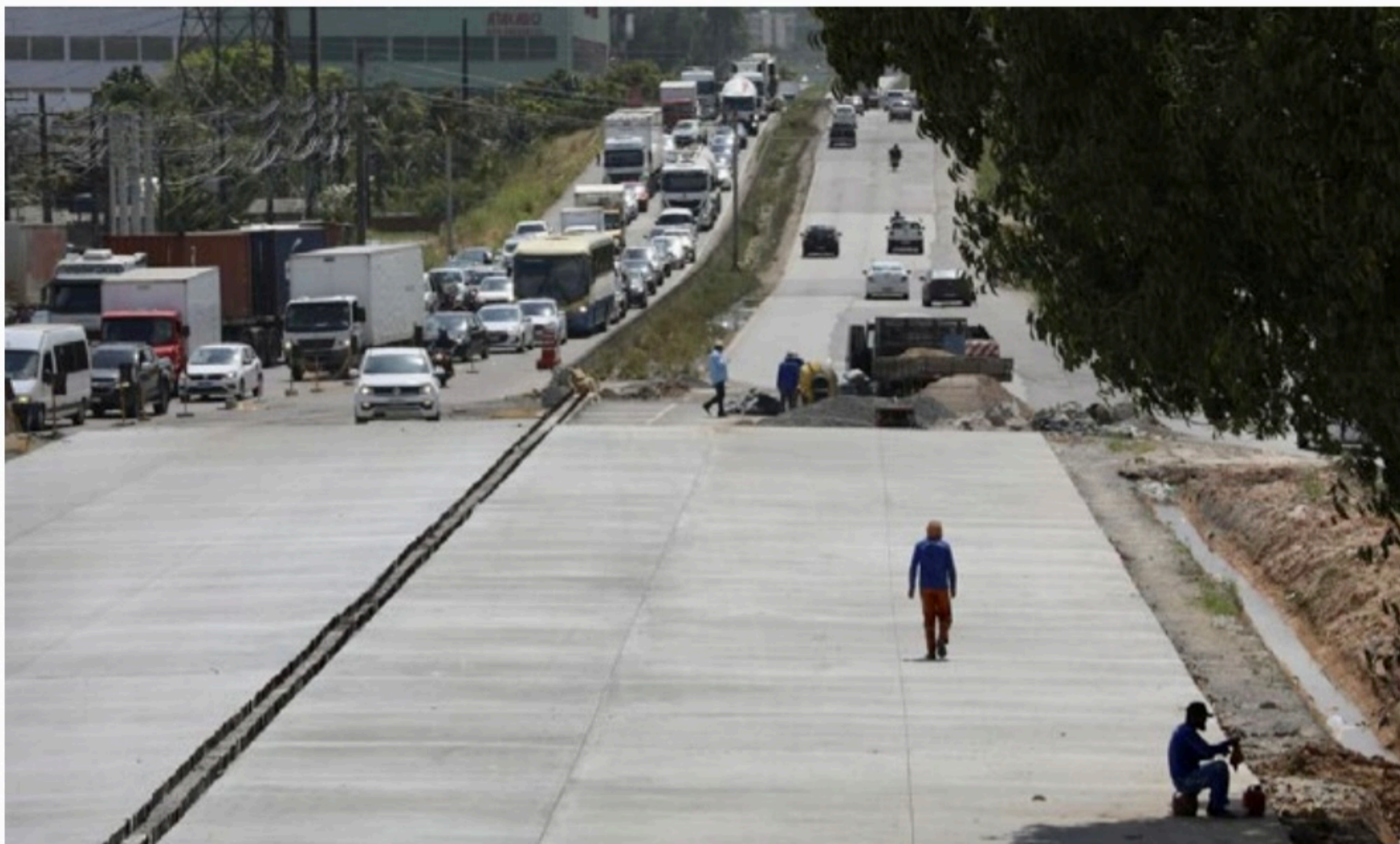
MELHORIAS Além da recuperação de todo o pavimento de concreto, a rodovia vai passar por um processo de urbanização e de integração com o transporte público
