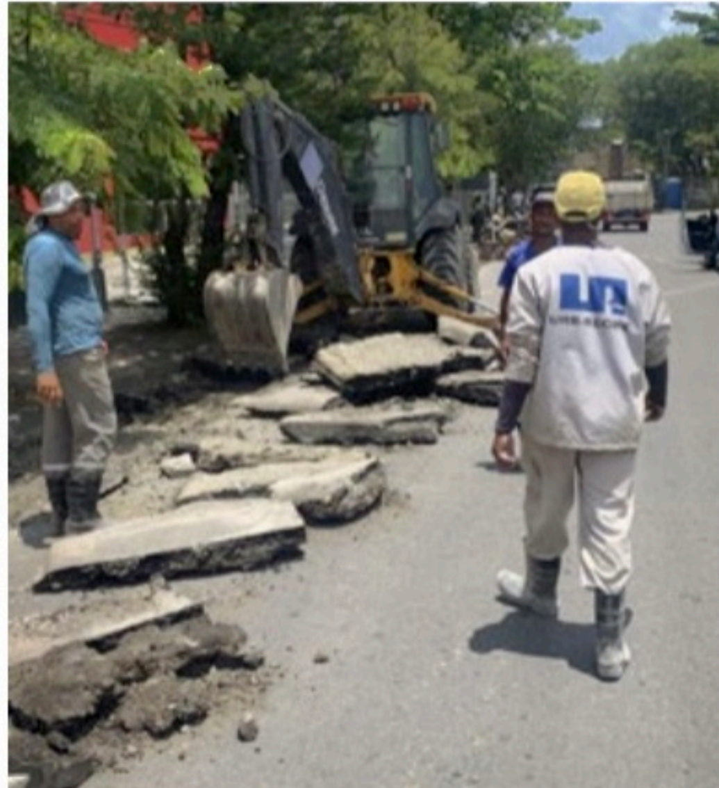
NOVA FASE Alargamento do pontilhão da Rua Pampulha começou ontem
