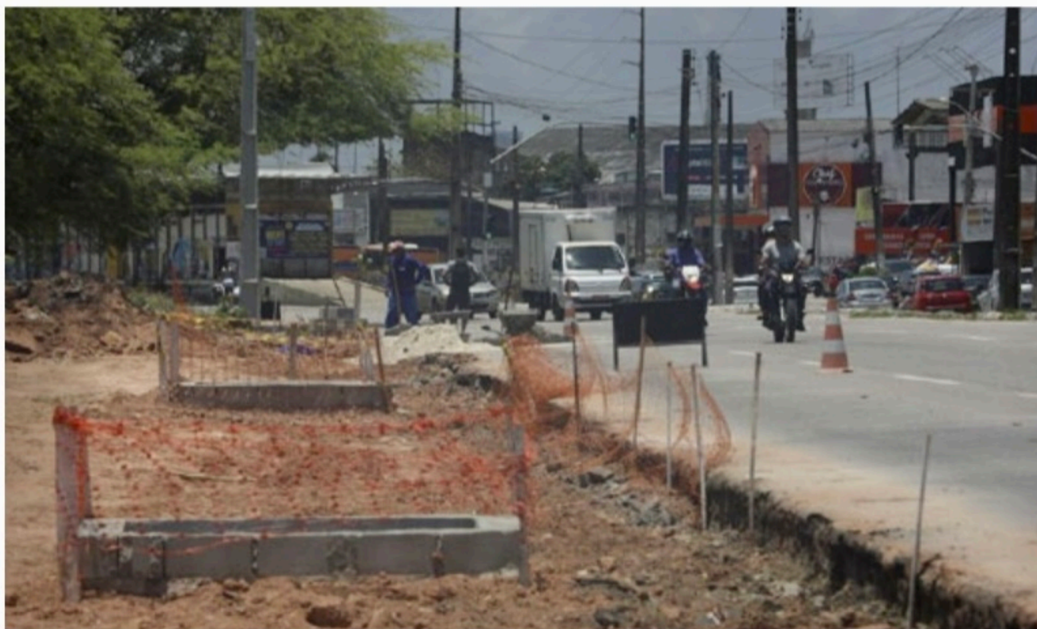
ALARGAMENTO Na Pan Nordestina, trabalho está sendo realizado entre a Estação de BRT Complexo de Salgadinho e o início da PE-15
