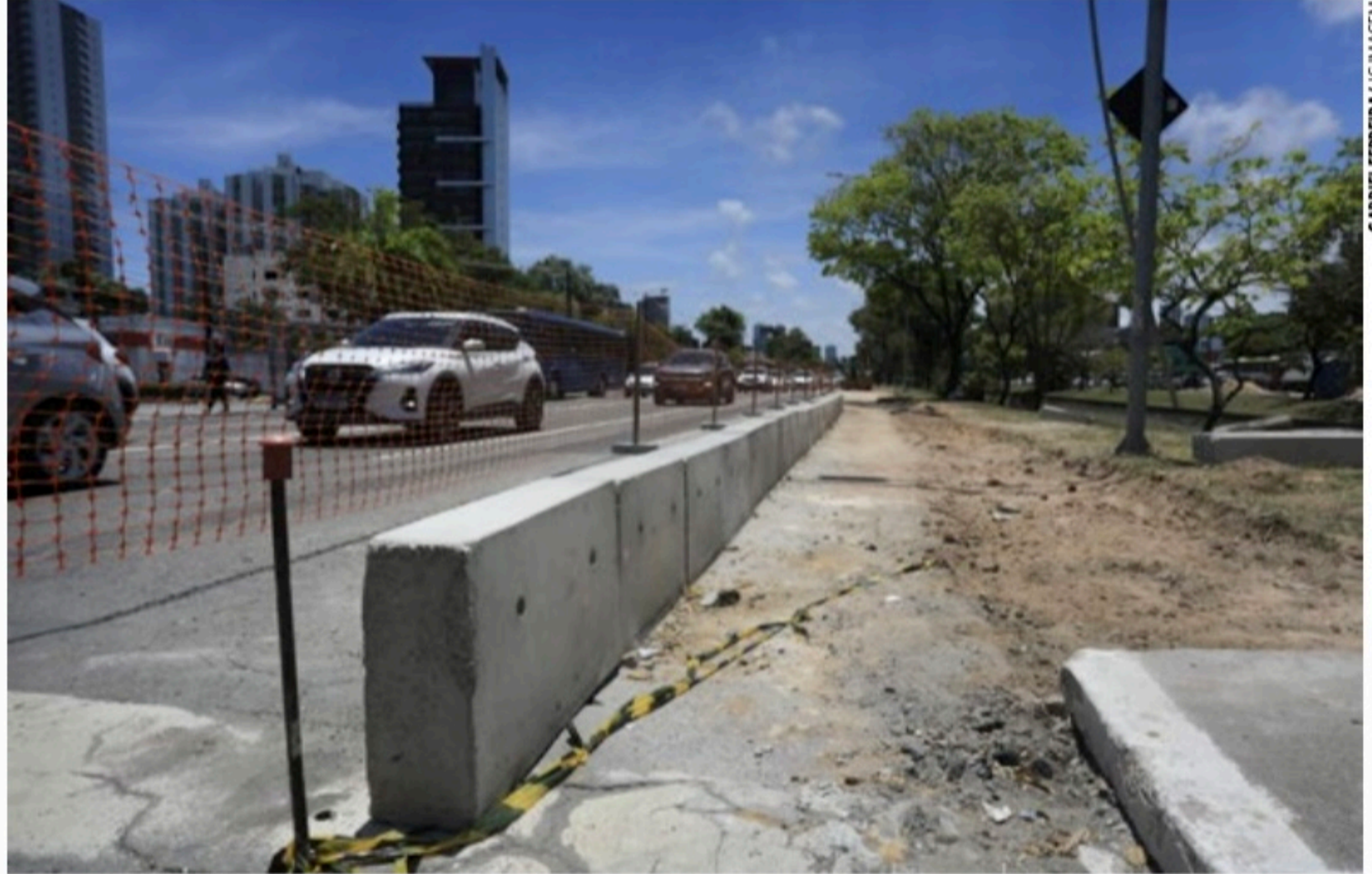
SERVIÇO Técnicos reduzirão largura das faixas da avenida de 3,3 para 2,9 metros, o que permitirá alargar em um metro o canteiro central
