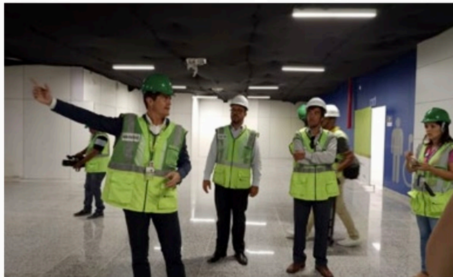
EMPREGABILIDADE Aena diz que 650 pessoas trabalham, atualmente nas obras; número pode chegar a 1.300
