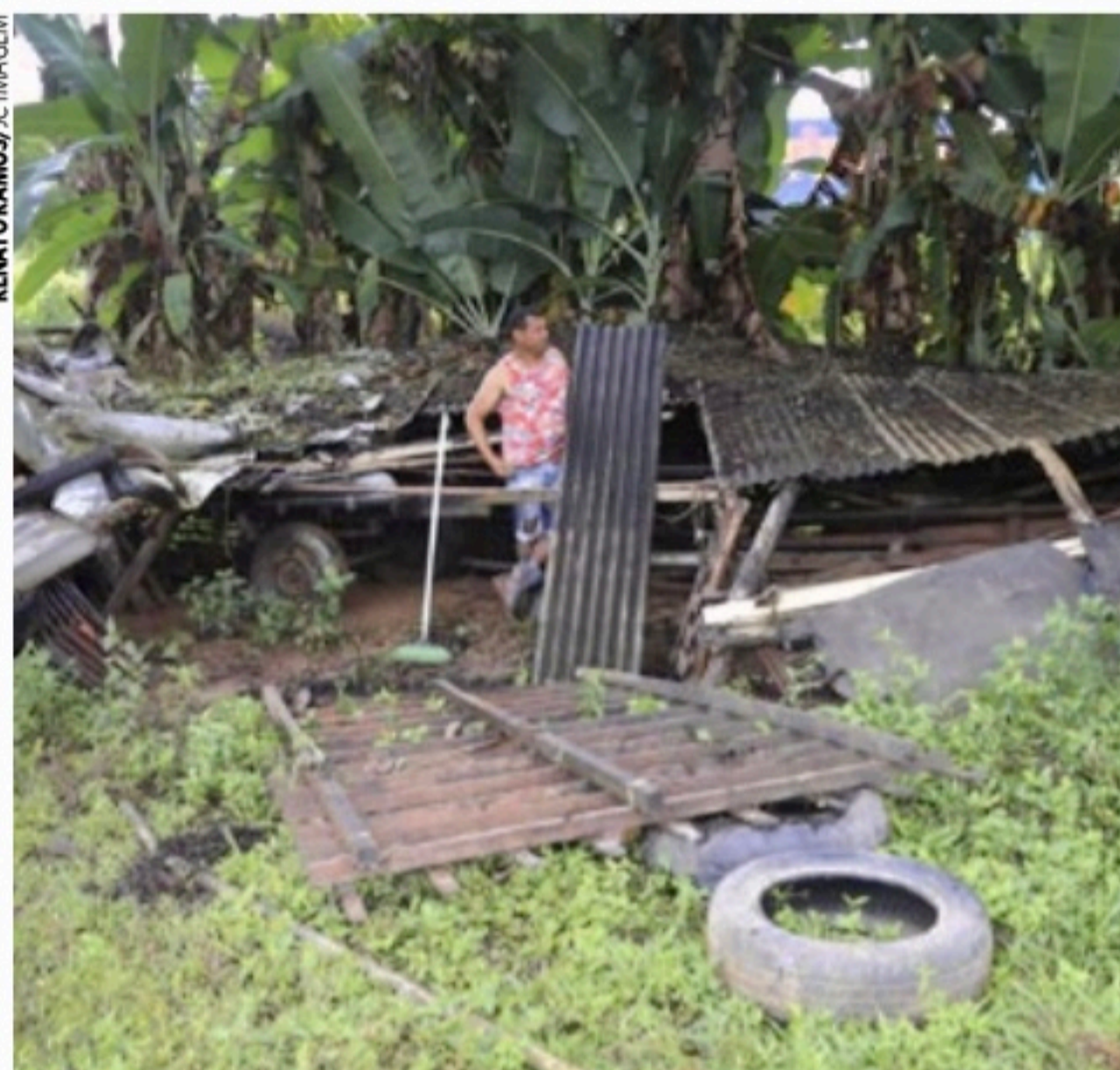
PREJUÍZOS Em Palmares, imóveis foram destruídos por causa do impacto da chuva
