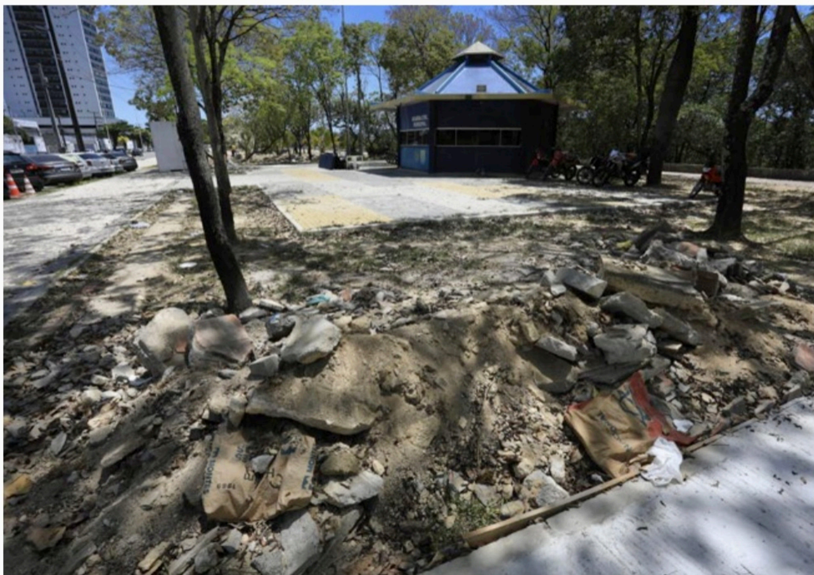
ABANDONO Há uma extensa área com vários entulhos e buracos aguardando reparos da gestão municipal. Pedestres e até ciclistas reclamam do risco de acidentes
