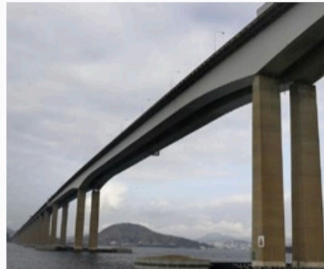
SEM RISCO Ponte Rio-Niterói foi liberada totalmente na manhã de ontem
