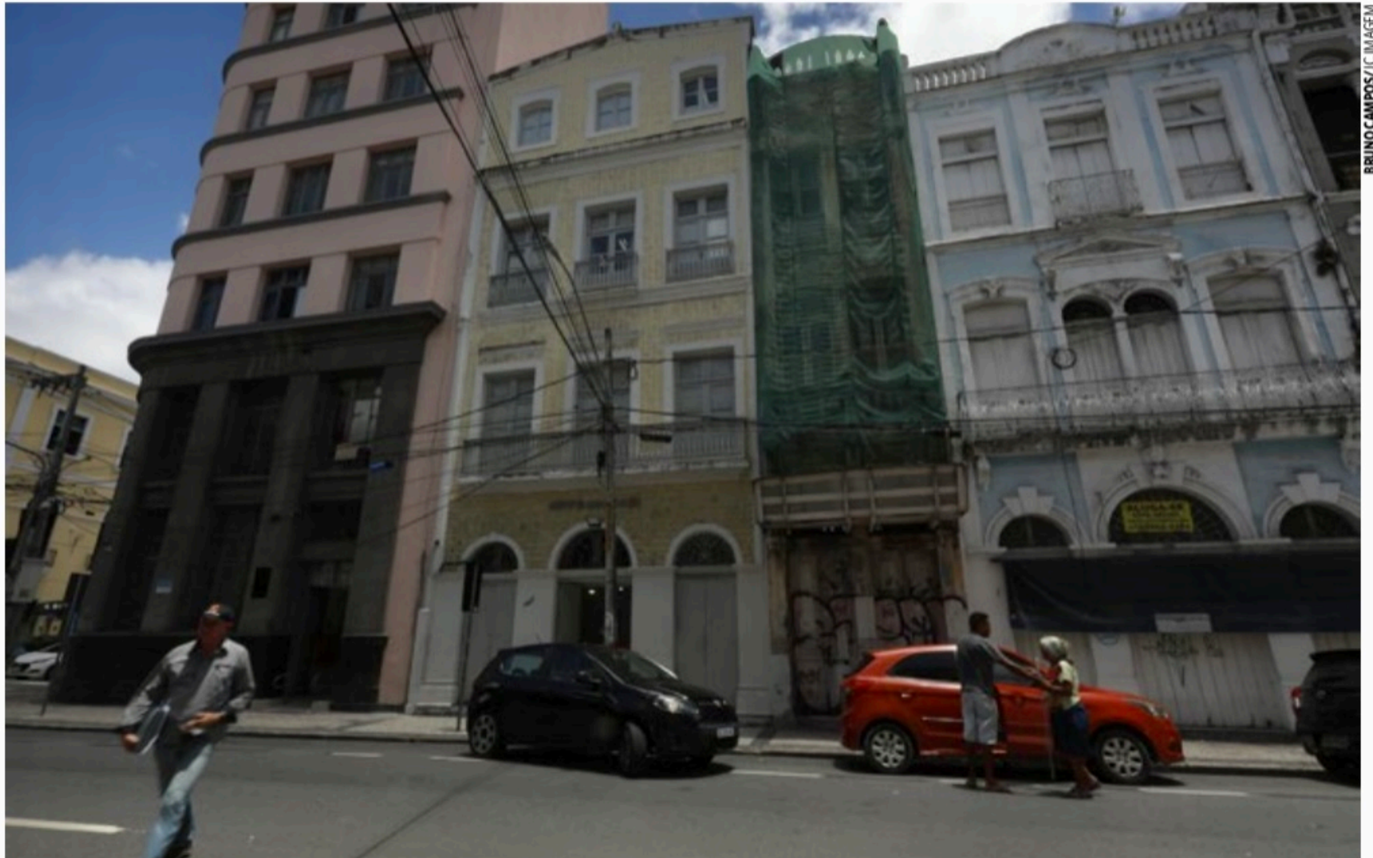
DESABITADOS Edifícios históricos na Rua do Imperador estão desocupados há anos e com riscos estruturais. Alguns, ao menos, contam com rede de proteção para evitar acidentes
