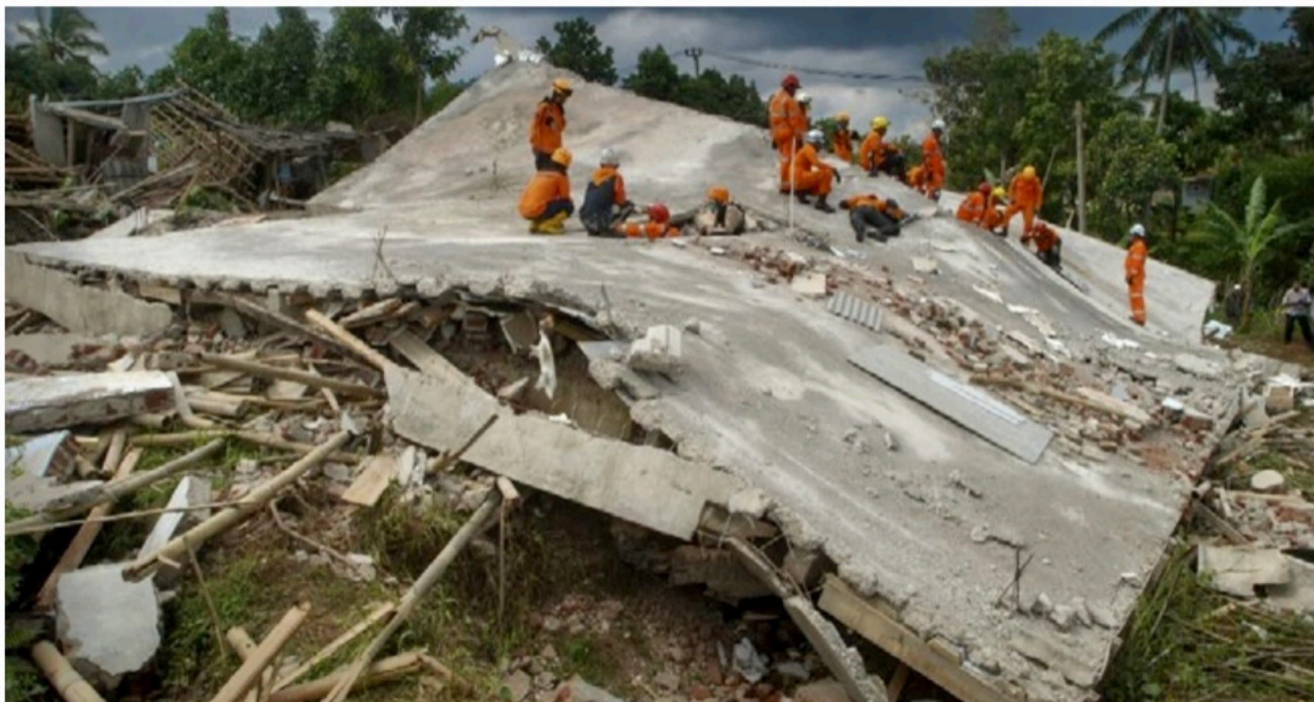
ESPERANÇA Equipes de emergência continuavam a trabalhar em áreas onde prédios desabaram em busca de sobreviventes, mas falta de equipamentos para mover escombros dificulta ação
