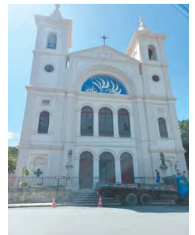
Construção católica está fechada desde 2013
