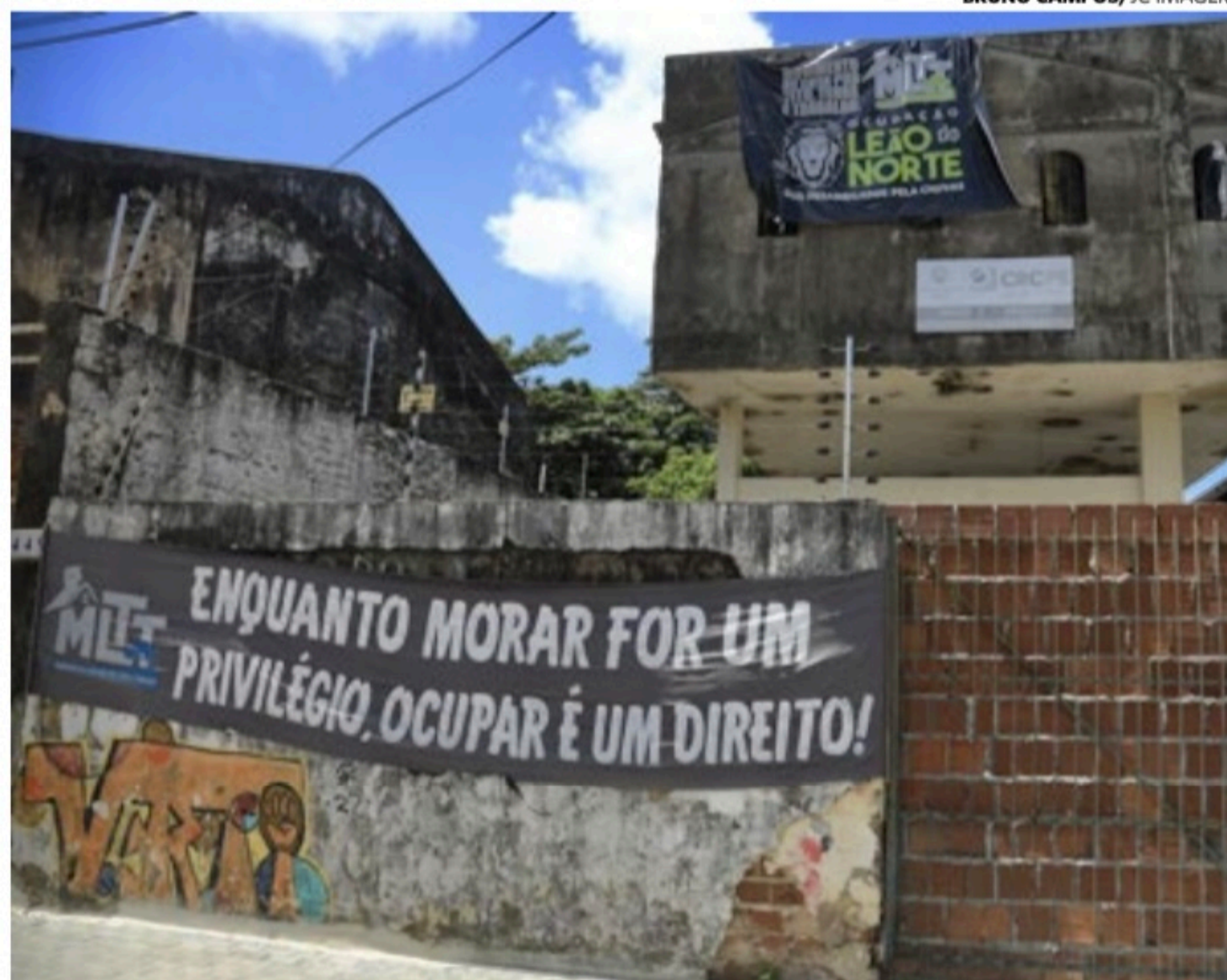
Ocupação no antigo prédio do Conselho Regional de Contabilidade de Pernambuco (CRC-PE), na Soledade, Centro do Recife
