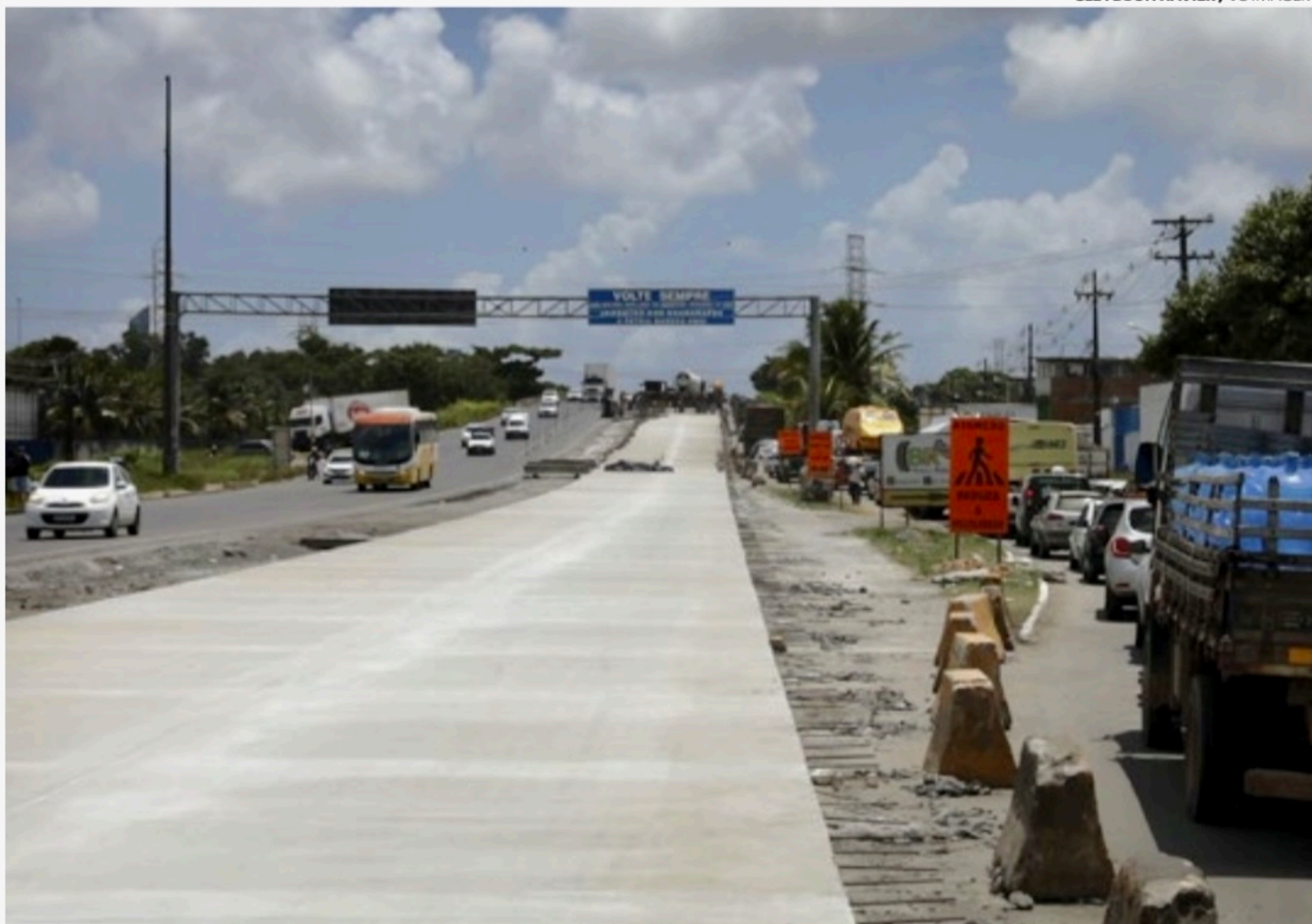
Obras causam maior trânsito
