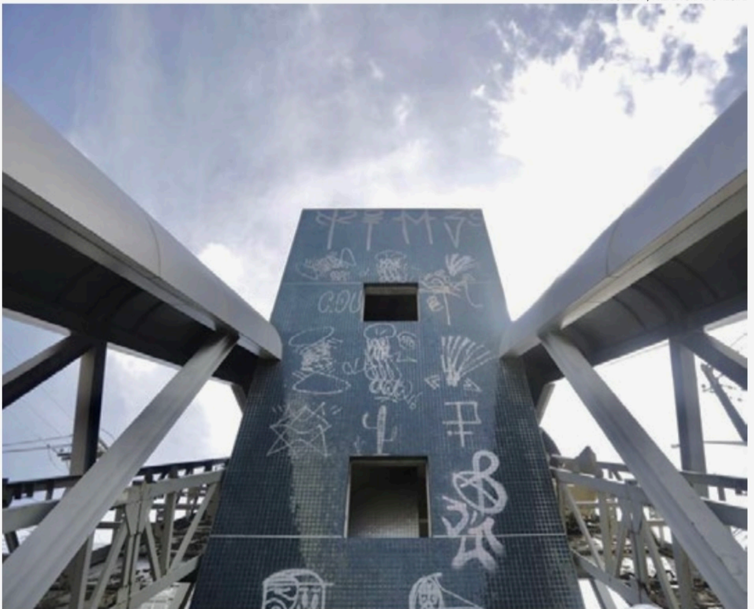
Passarela do Pina, sobre o Túnel da Via Mangue, começa a ser recuperada após mais de dez anos de degradação na principal entrada da Zona Sul do Recife
