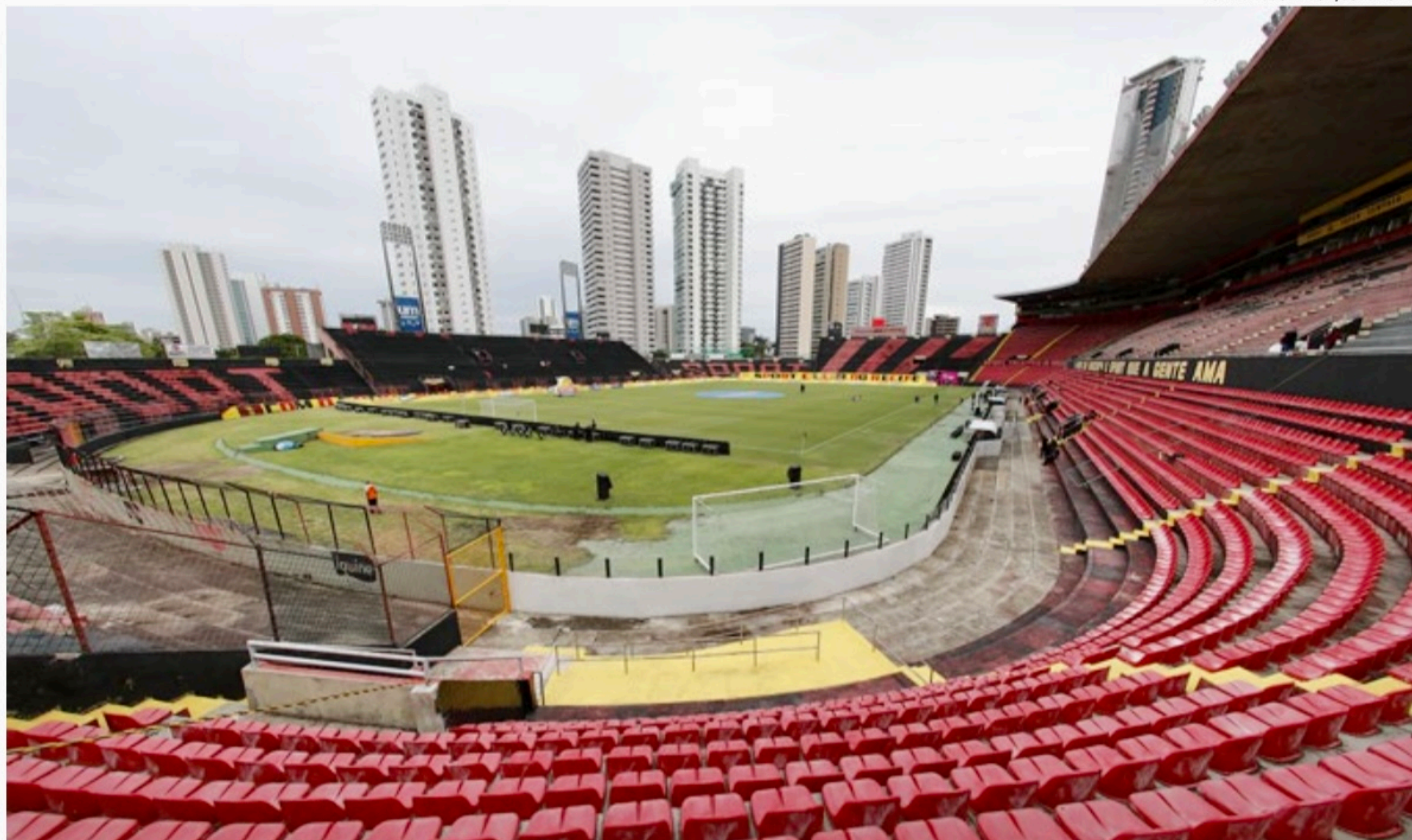
A Ilha do Retiro: o campo do Sport é plantado sobre o mangue lamacento - e mangue não drena
