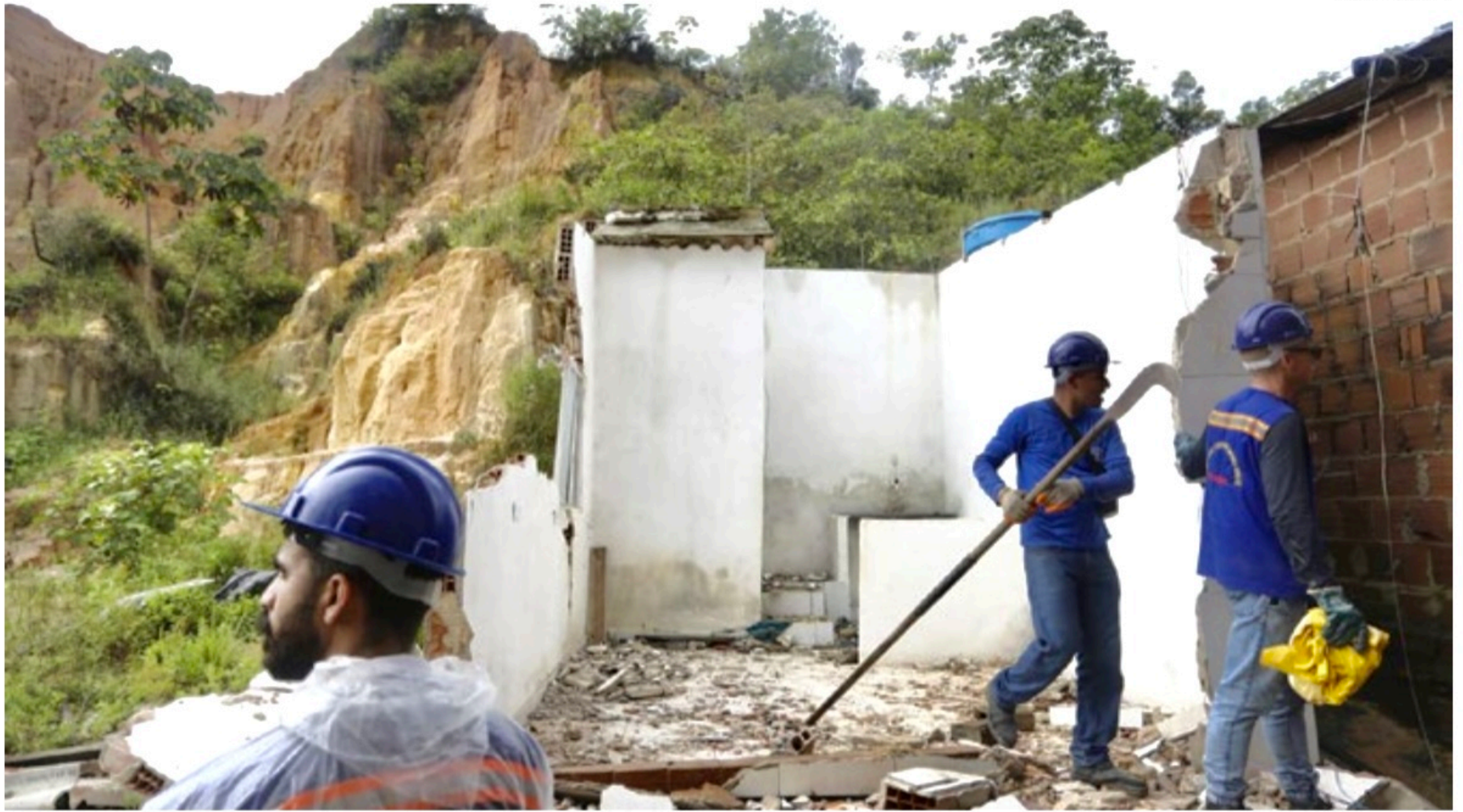
As 26 casas também são demolidas por equipes da Prefeitura do Recife
