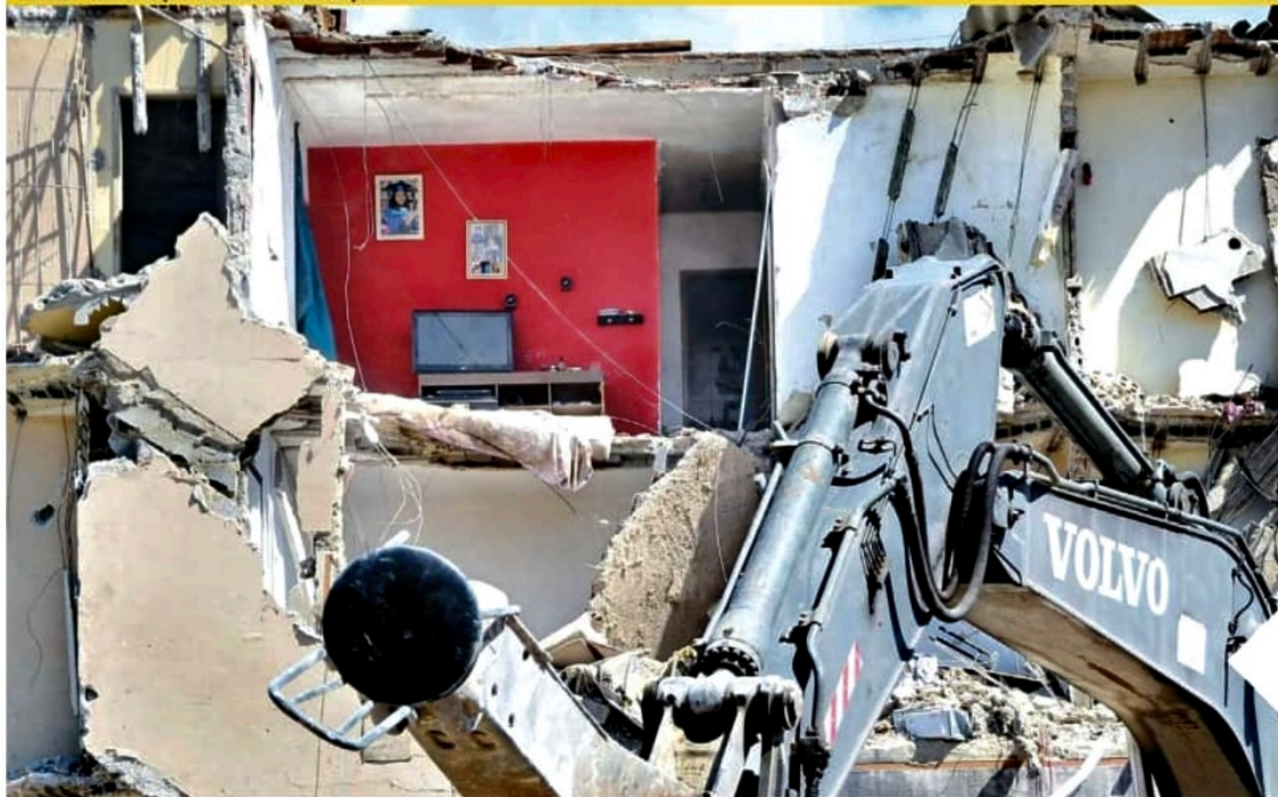
Demolição do que restou do prédio continuou ontem, com recuperação de bens dos desalojados
