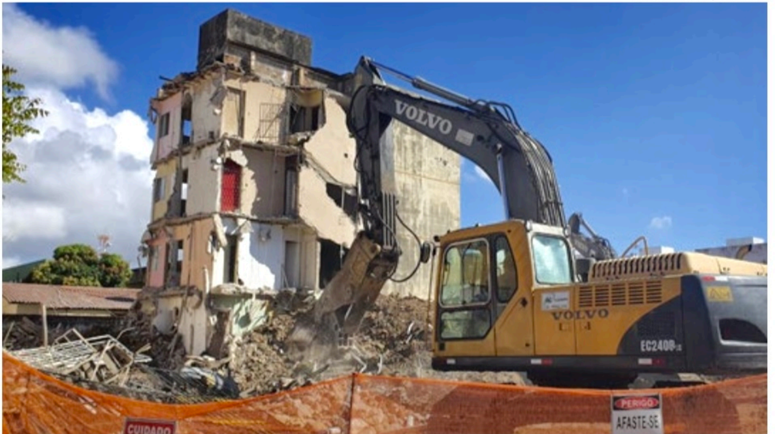
Demolição do Edifício Leme chega à fase final nesta terça-feira (2)
