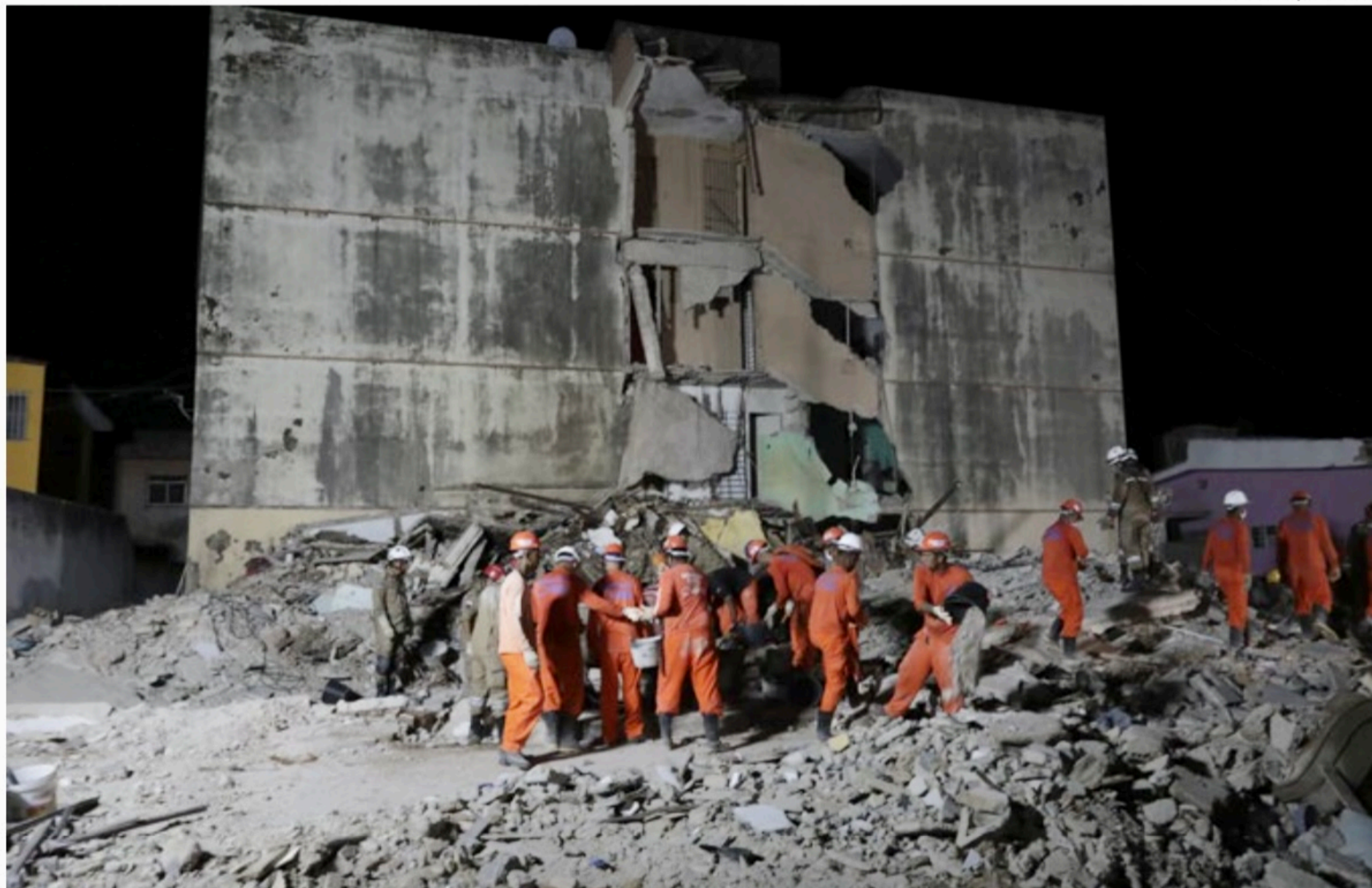
Edifício Leme desabou no dia 27 de abril, em Olinda, deixando seis mortos
