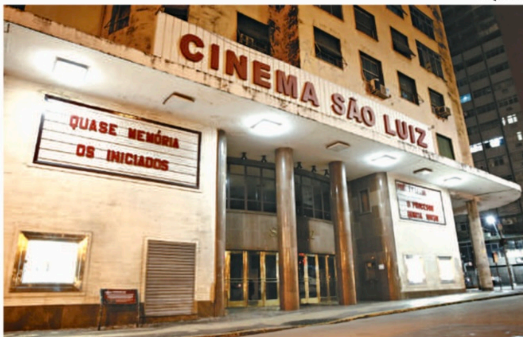
O cinema passou por quatro obras, mas problemas no esgotamento de águas persistiram
