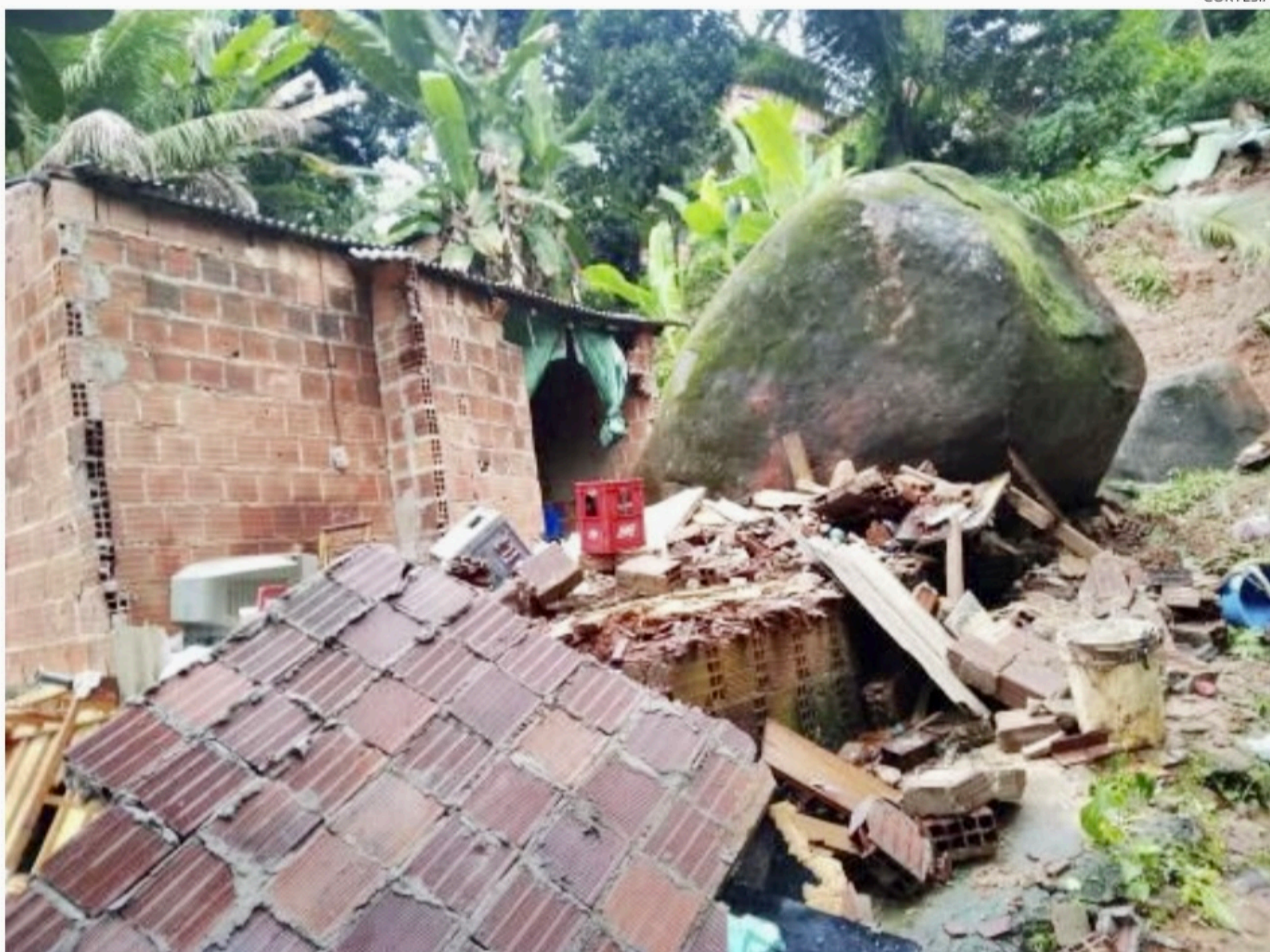
Pedra desliza e atinge casa no bairro da Muribeca, em Jaboatão dos Guararapes
