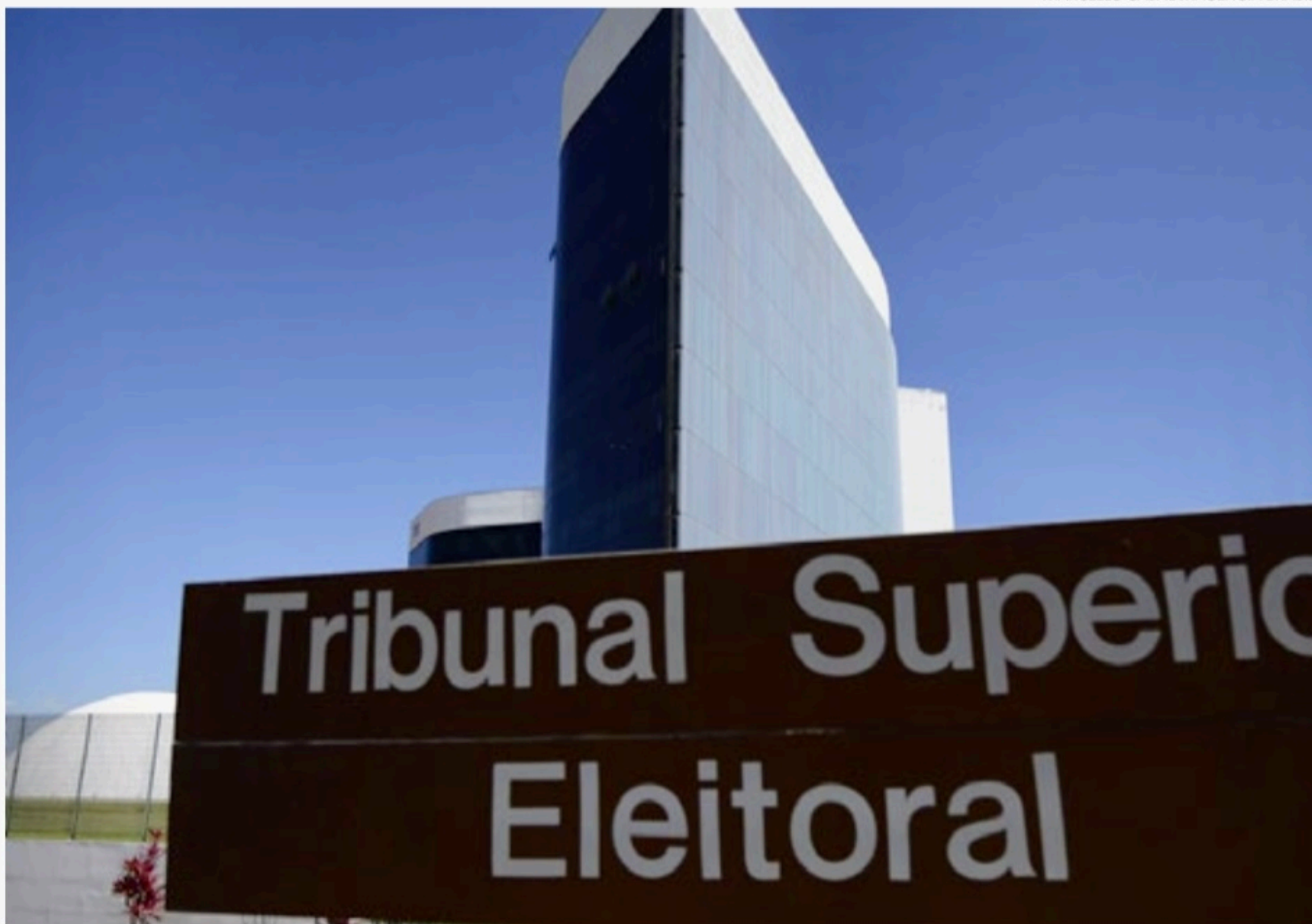
Fachada do edifício sede do TSE
