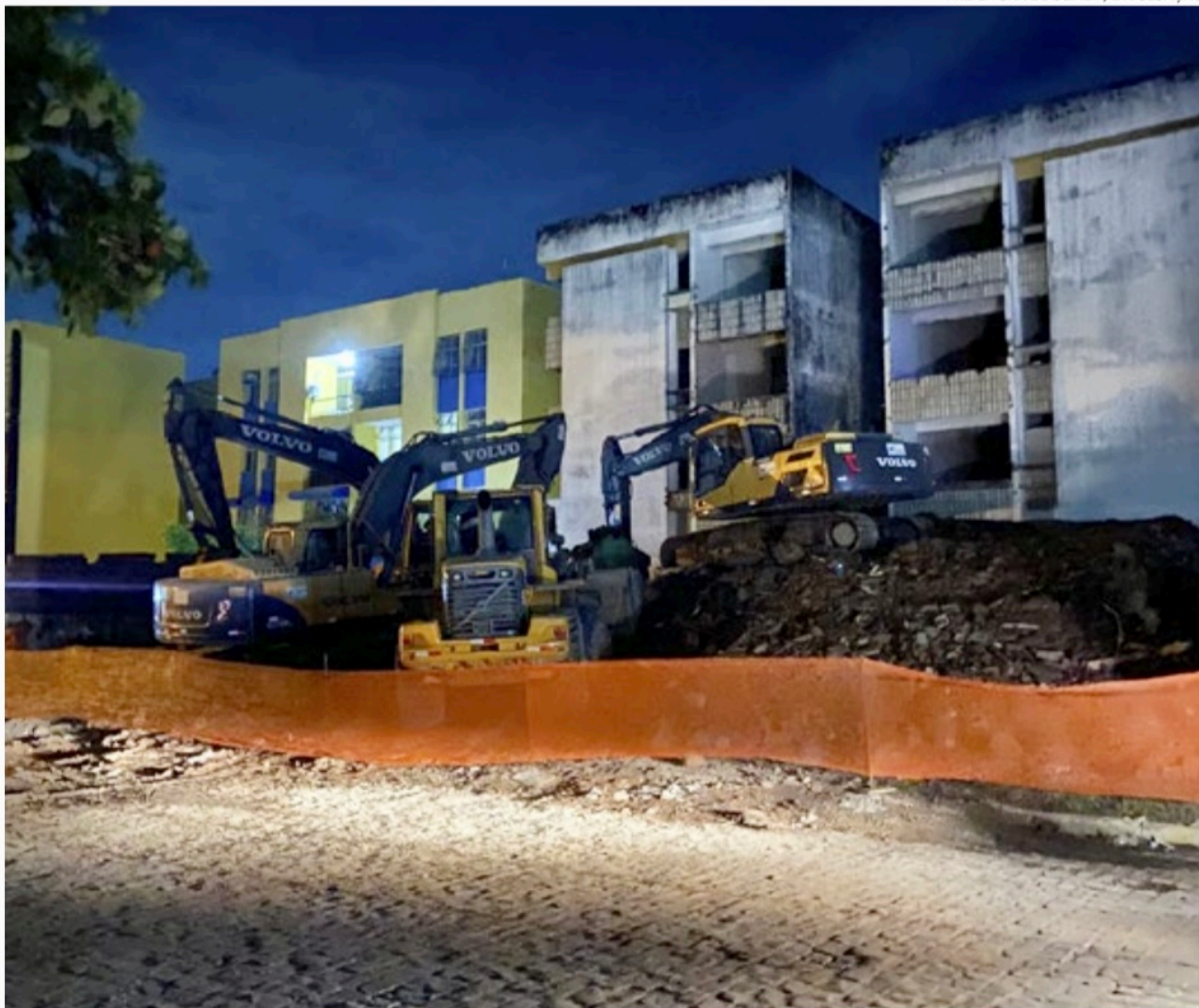
Edifício Alfredo Lopes, em Olinda, é demolido
