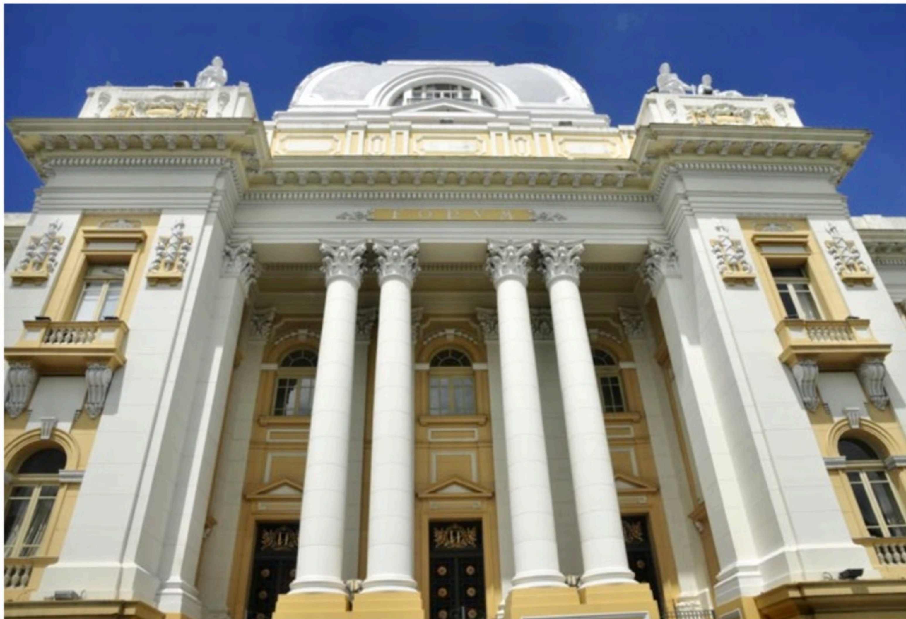
Prédio do TJPE, sede do Judiciário estadual
